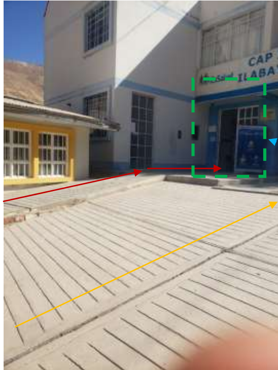
RAMPA PARA PERSONAS CON DISCAPACIDAD
