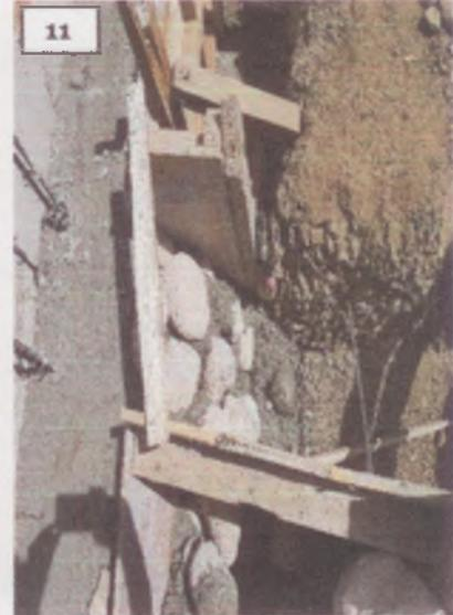
10.- Cimientos con agregados no embebidos en concreto expuestos a la cara lateral.
