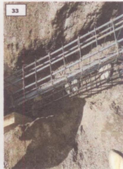
32, 33.- Acero en vigas de cimentación con pandeo horizontal por falta de incorporación de elementos que garanticen su horizontalidad, ya que solo cuentan con piedras de diversos diámetros.
