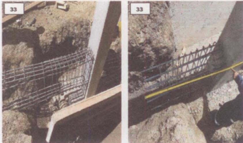
34, 35.- Traslape de acero horizontal realizadas en el primer tercio (positivo y negativo) de la viga de cimentación (costados de las columnas).
