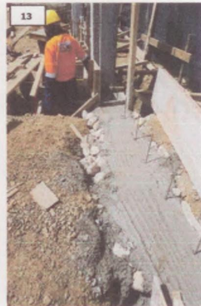
12, 13.- No se emplea adecuadamente el encofrado para el baseado de cimientos. Falta de alineamiento vertical y horizontal. Uso de piedras de grandes dimensiones.
