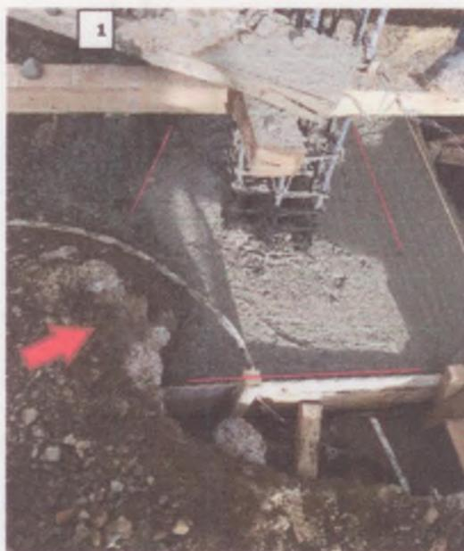
1.- Roca en la altura de la zapata; sin embargo, no fue extraída previo al baseado del concreto, conllevando a una reducción del área de contacto estructura-suelo.
