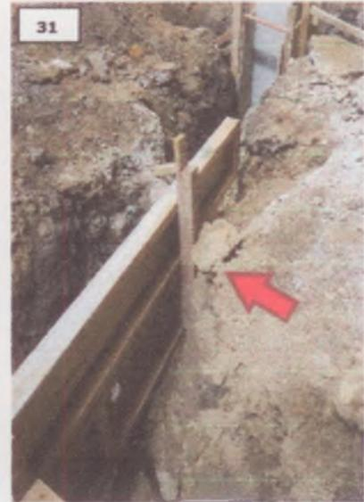
30, 31.- Elementos de encofrado sin seguros horizontales, apoyados sobre terreno natura o nivelados con piedras.
