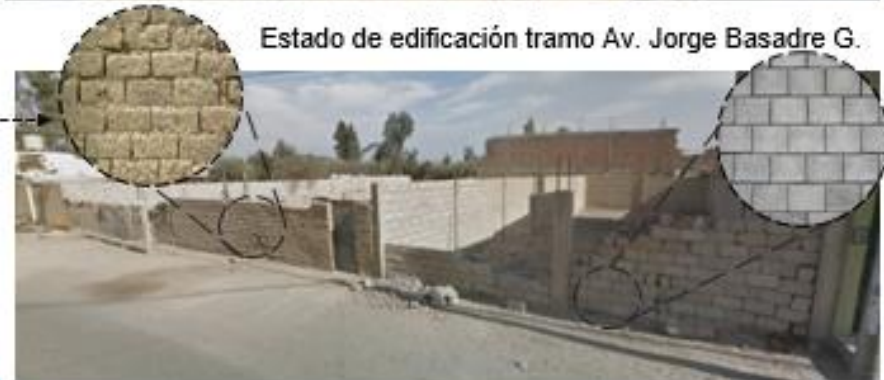
Estado de edificación tramo 28 de agosto.
