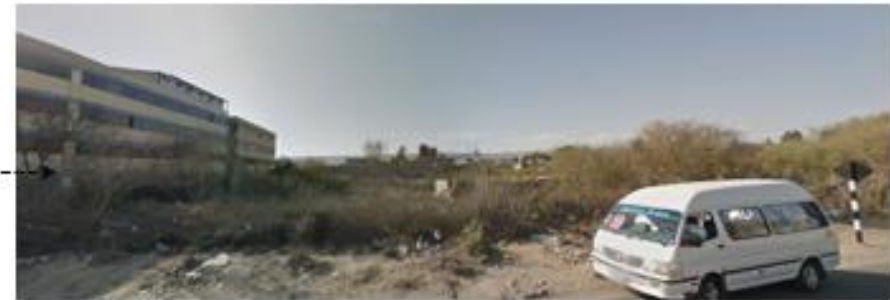
Estado de edificación tramo Av. Jorge Basadre G.
