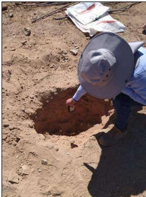
*Nota.* En la figura 12 se muestra la excavación de la calicata 2 donde se ubicará el punto de descarga.
