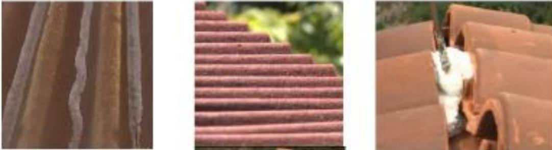
Imagen 06, 07,08: sistema Onduline compuesto por paneles termo-acústicos tipo sándwich.
