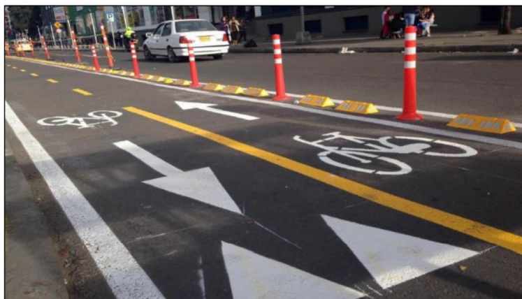
Figura 17 Ejemplo de ciclovía con elementos de confinamiento
