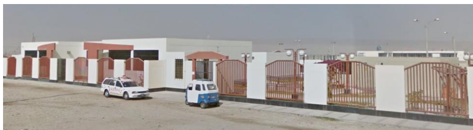
Imagen N° 39. Fachada del Centro de Desarrollo Social para Personas con Discapacidad
