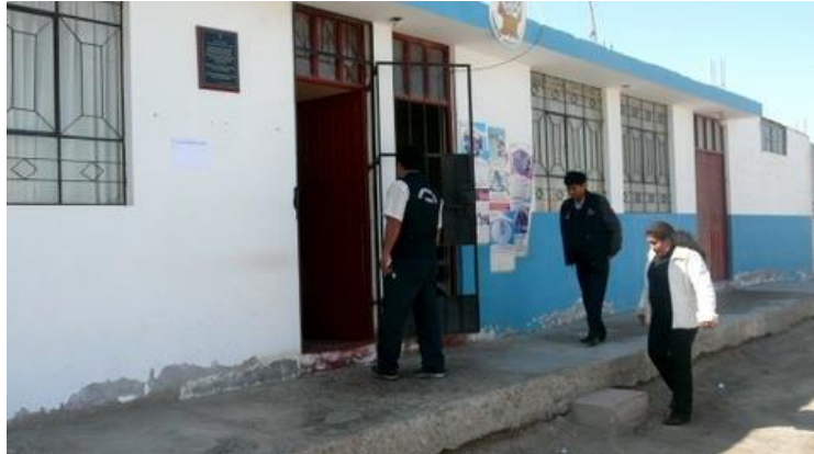
Imagen N° 33. Institución que no Tienen Rampas para Personas con Discapacidad
