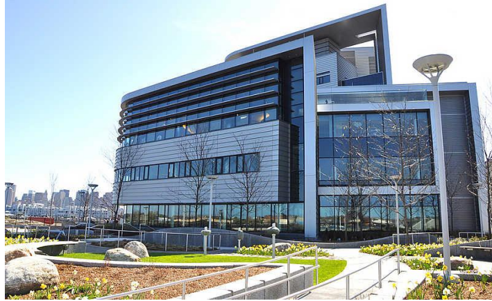
Imagen N° 17. Fachada del Hospital de Rehabilitación de Spaulding
