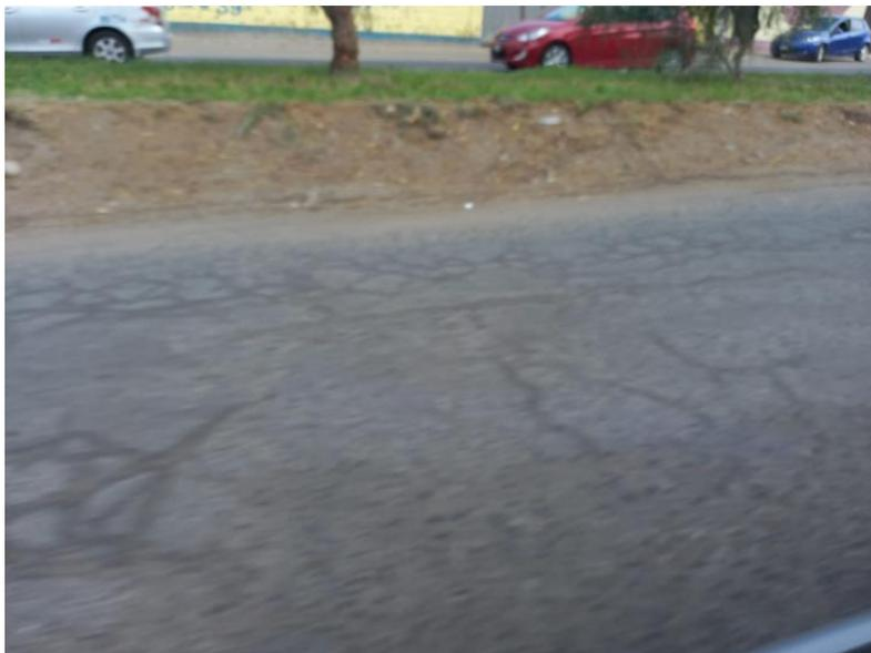
*Nota.* En el pavimento correspondiente a la Av. Circunvalación Sur, se observa piel de cocodrilo de malla mediana (entre 0.3 y 0.5 m) con material suelto.
