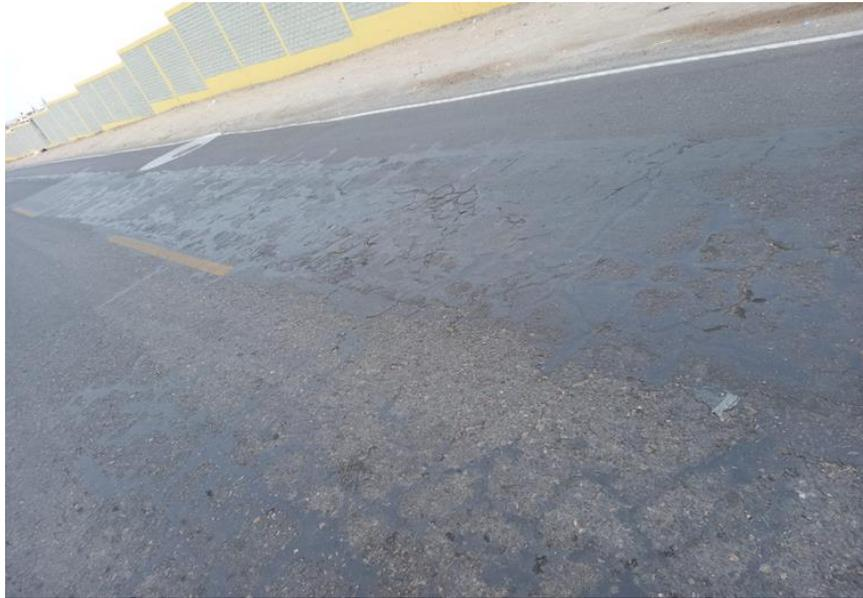
*Nota.* En la av. Collpa paralelo al CEA III UNJBG " FUNDO LOS PICHONES" se observa reparación de piel de cocodrilo o de fisuras longitudinales, en mal estado.
