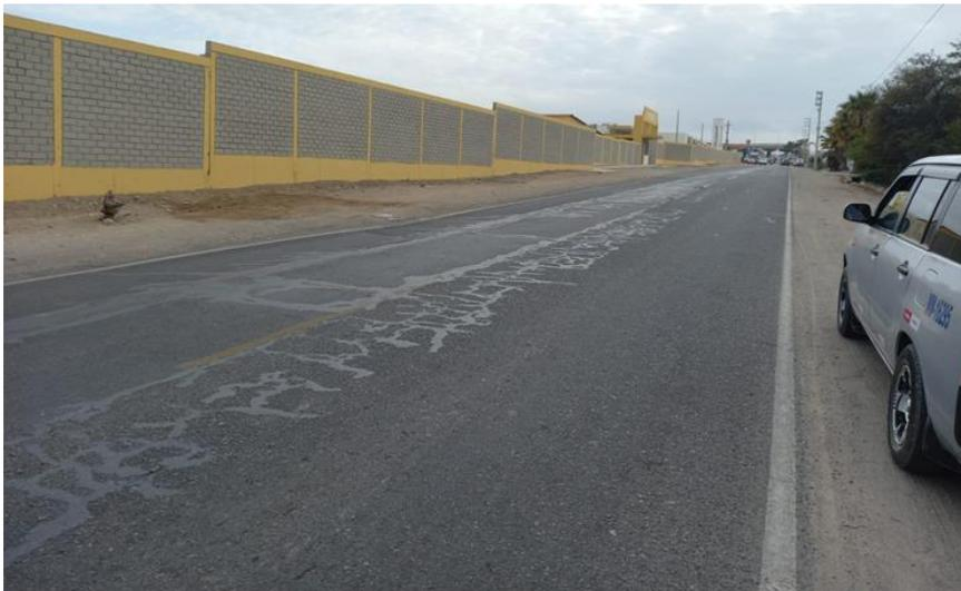
*Nota.* En la vía de av. Collpa paralelo al CEA III UNJBG " FUNDO LOS PICHONES" se observa parchado de fisuras continuas, en mal estado. Así como desprendimiento de agregado superficial.
