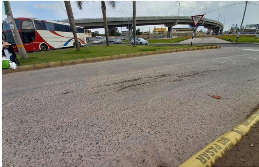
*Nota.* Finalizando la av. Collpa, paralelo al mercado de Productores La Agronómica se visualiza desgaste superficial y desprendimiento de la carpeta de rodadura del pavimento.
