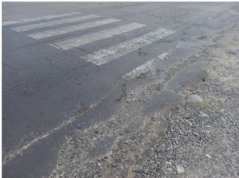
*Nota.* Av. Circunvalación Sur, se visualiza desprendimiento de agregados, y fisuras longitudinales y transversales.
