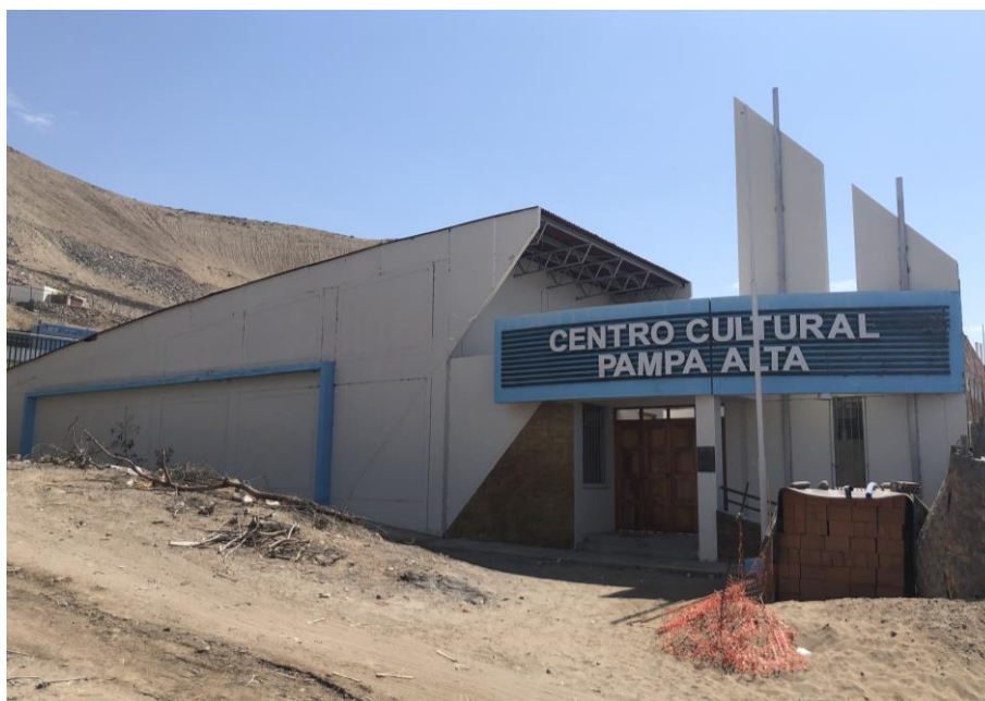
Figura 5: Centro Cultural de Pampa Alta construido en el año 2012.
