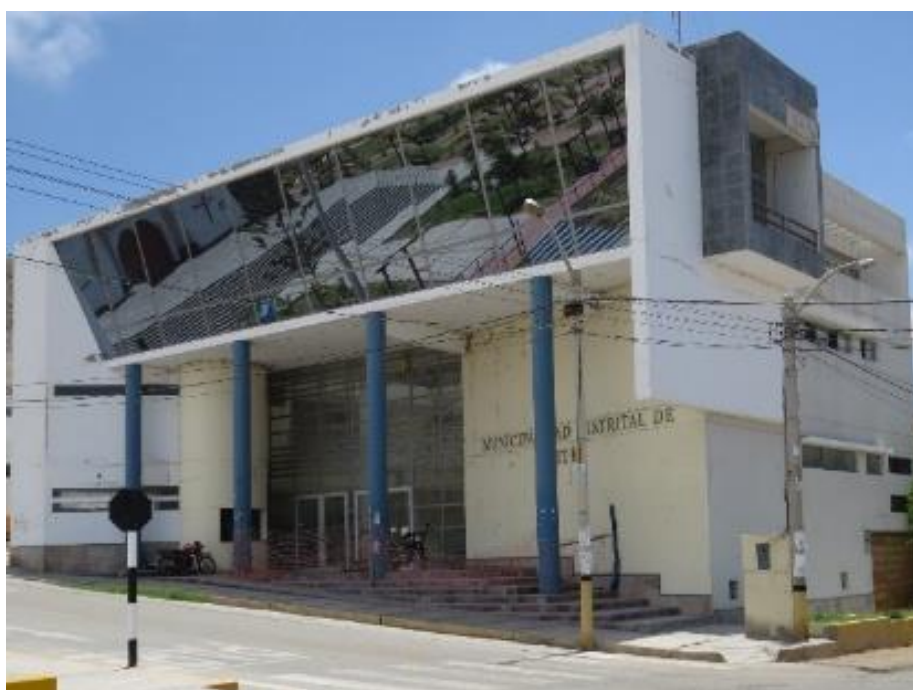
Figura 4: Municipalidad distrital de Ite construida en el año 2009.
