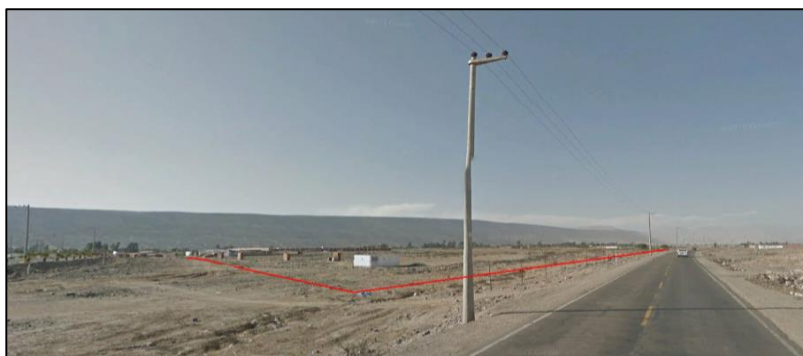
Figura 57: Servicios red eléctrica
