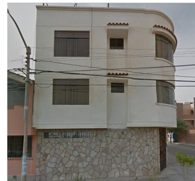
Figura 52: Vivienda 03 niveles de concreto- ladrillo Fuente: Propia
