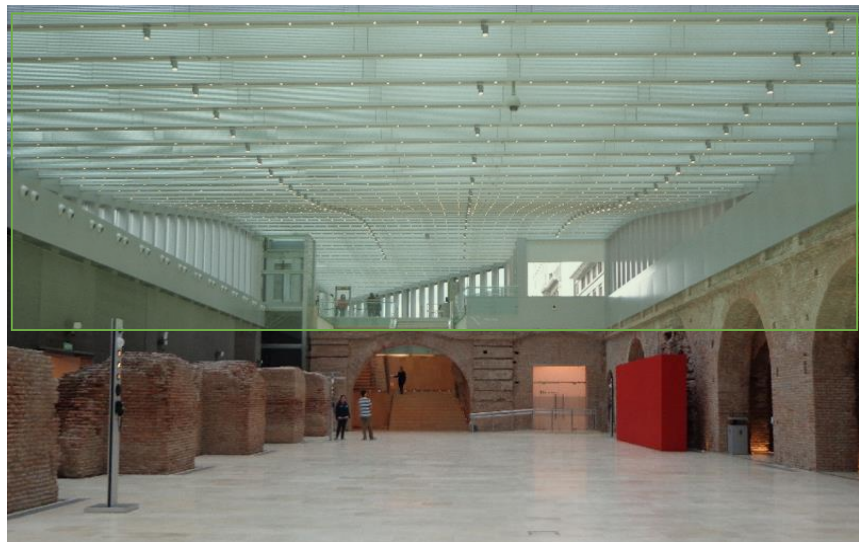
Figura 12.- Vista de la cubierta del Museo
