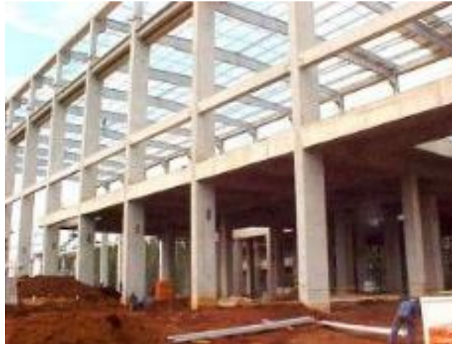
Figura 56: Armazón de concreto armado Fuente: Internet
