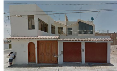
Figura 50: Vivienda 02 niveles de concreto- ladrillo Fuente: Propia
