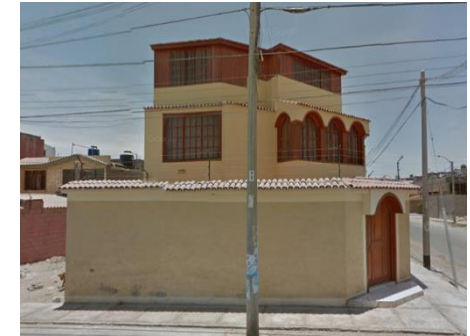
Figura 51: Vivienda 02 niveles + azotea de concreto- ladrillo Fuente: Propia
