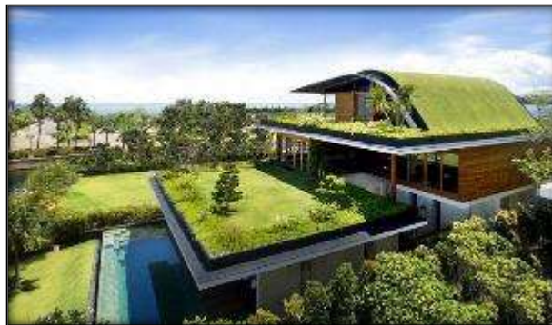
FIGURA N° 13: Azotea verde semi-intensiva o mixta
