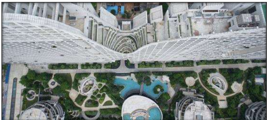
FIGURA N° 75: Vista Aérea de la Cima de las Colinas Artificiales
