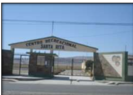
FIGURA N° 129: Centro Recreacional en Santa Rita - Calana)
