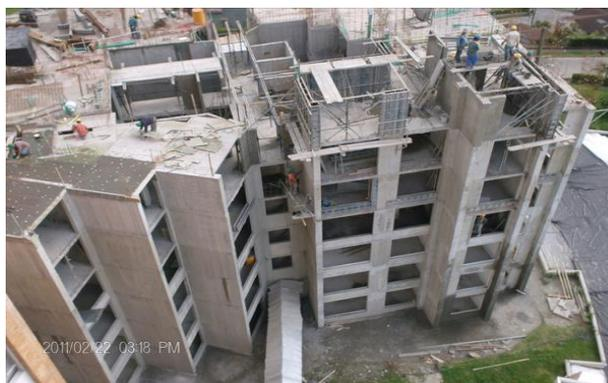
*Nota.* Sistema estructural de muros estructurales.
