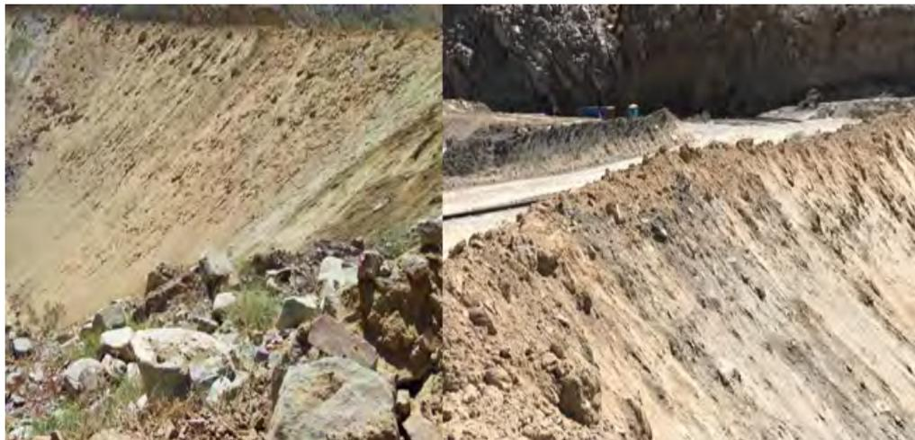
*Arcilla Consolidada.* Formada por la acumulación y/o represamiento de material aluvial fino; de color amarillo crema; se le ha reconocido en el talud aguas abajo en la parte media y superior, en el talud aguas arriba en el medio y en la parte superior y en la margen derecha lateral; en esta parte gradualmente contiene bolones (< 0.3 m) de roca angulosa a subangulosa, este material se muestra en la Figura 47.
