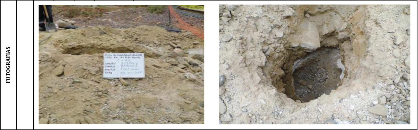
**OBSERVACIONES:** Existe una excavacion masiva, no se observa presencia de napa freatica a una profundidad de 1.20ml, respecto al terreno natural.
