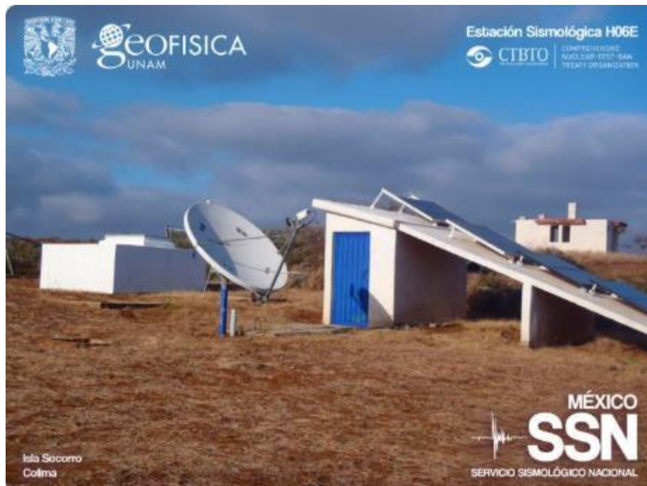
Figura 32 Estación de Isla Socorro
