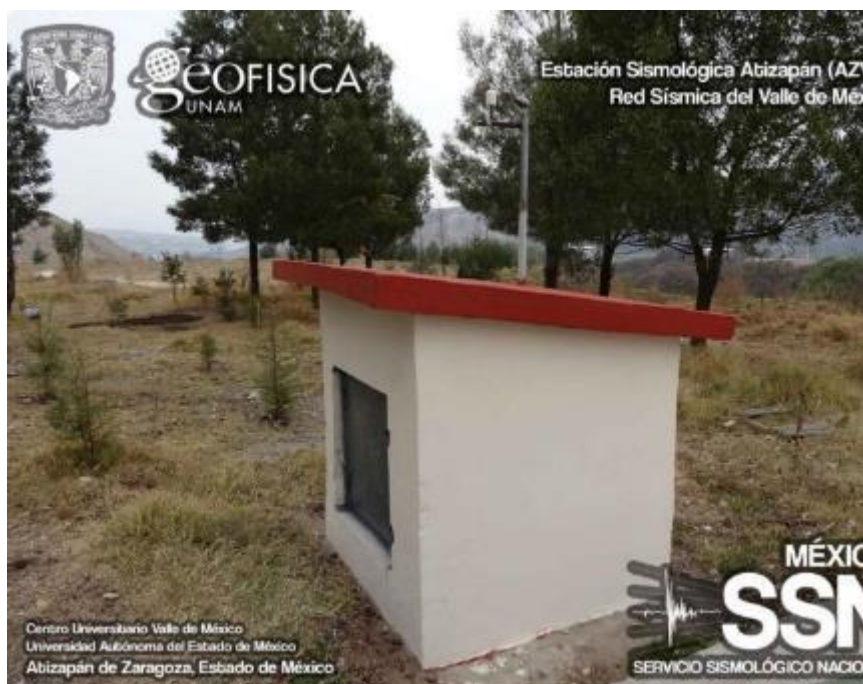
Figura 28 Estación de Atizapán
