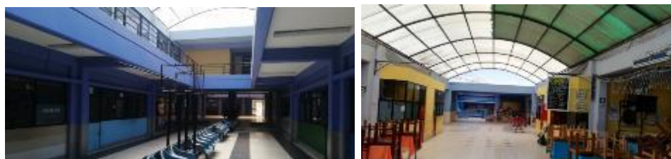
PRIMER NIVEL – ALBAÑILERÍA
