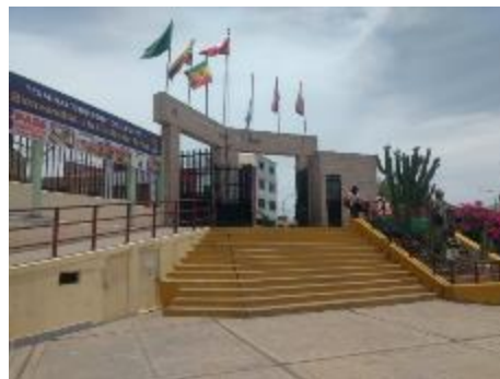
Figura 35. Portada de ingreso del Terminal Collasuyo.
