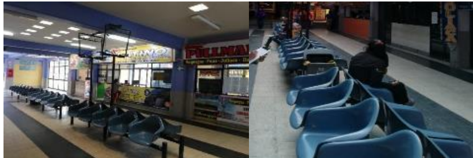
Figura 46. Espacios con problemas en iluminación – sala de espera.
