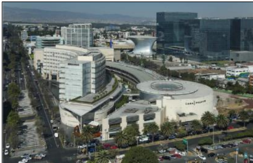
Figura 26. Aspecto formal B del centro comercial Antara F.
