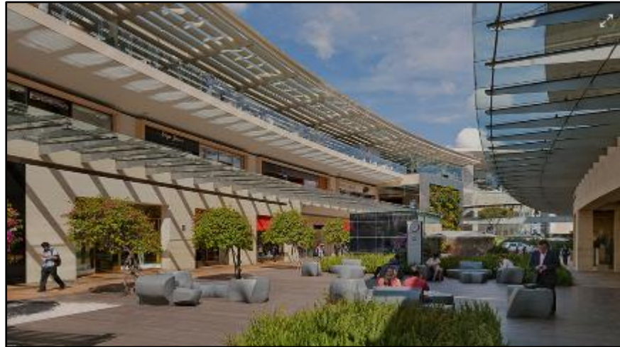
Figura 20. Vista del pasillo del centro comercial Antara F.
