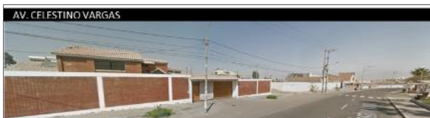
Figura 78. Estado de edificación de Av. Celestino Vargas
