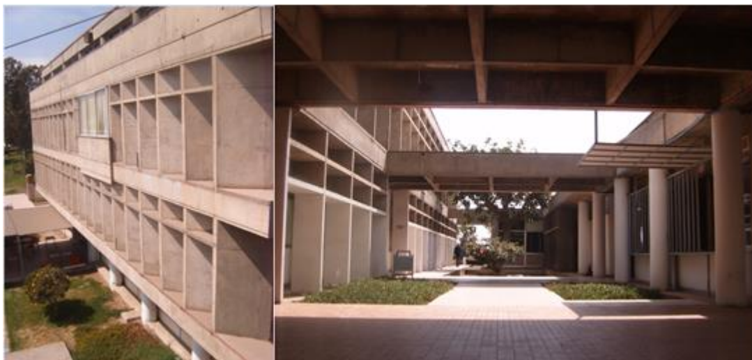
Figura 198: Fotografías fachada poniente bloque central del conjunto y patios laterales
