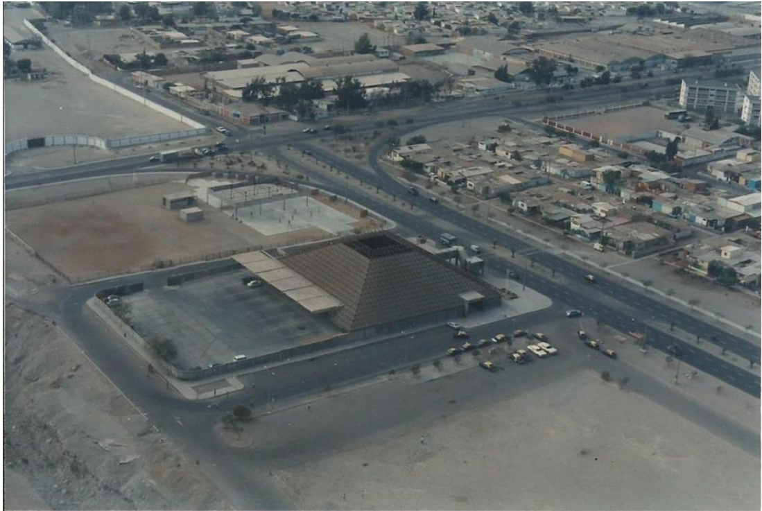
Figura 335: Foto exterior, fachada Oriente. Nota: Diario la estrella de Arica.
