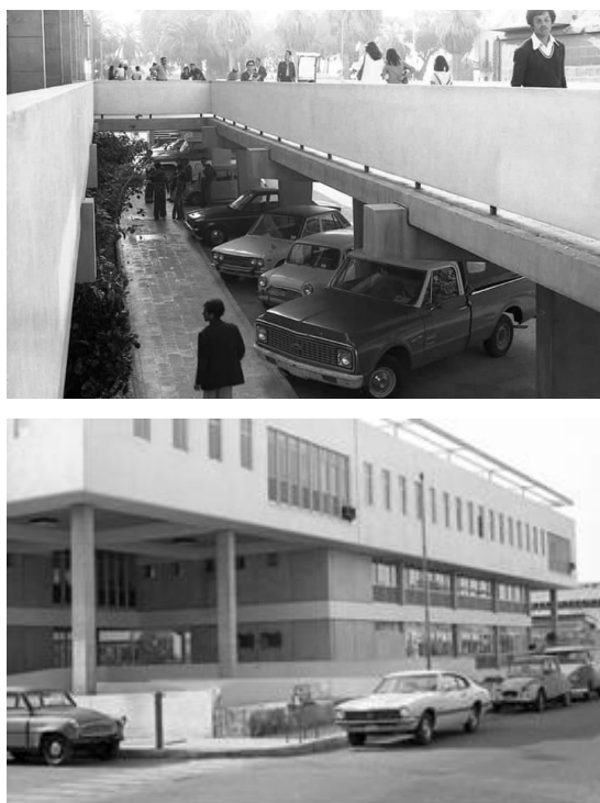
Figura 349: Foto pasarela aérea de acceso y esquina Suroriente Nota: Archivo histórico Vicente Dagnino.
