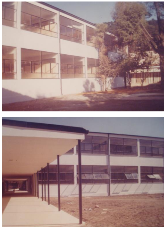
Figura 151: Foto fachada bloque de salas de clases e interacción con vegetación existente y pasillo conector, patio intermedio y bloque de salas de clases Nota: Archivo personal Oscar Macclure, 1961.
