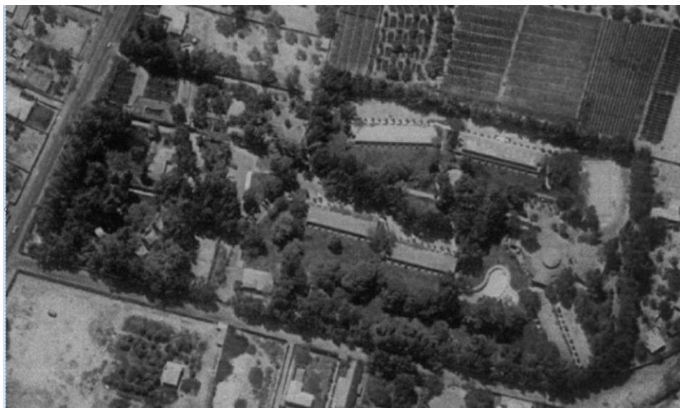
Figura 73: Fotografía aérea 1970 - Motel Azapa
