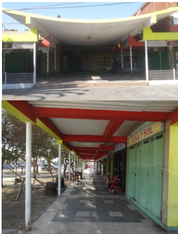
Figura 279: Foto acceso y pasillo exterior, Mercado Loa, 2017. Nota: Del autor.
