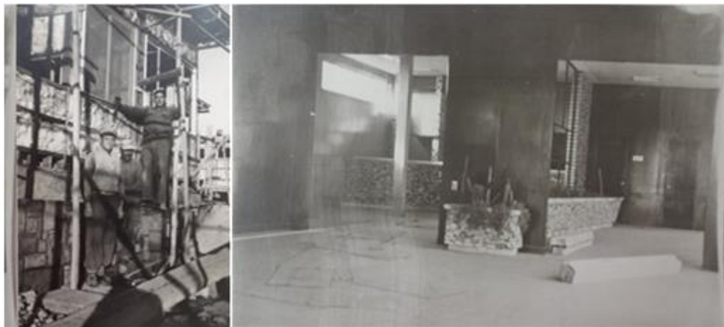
Figura 64: Foto construcción del hotel el paso
