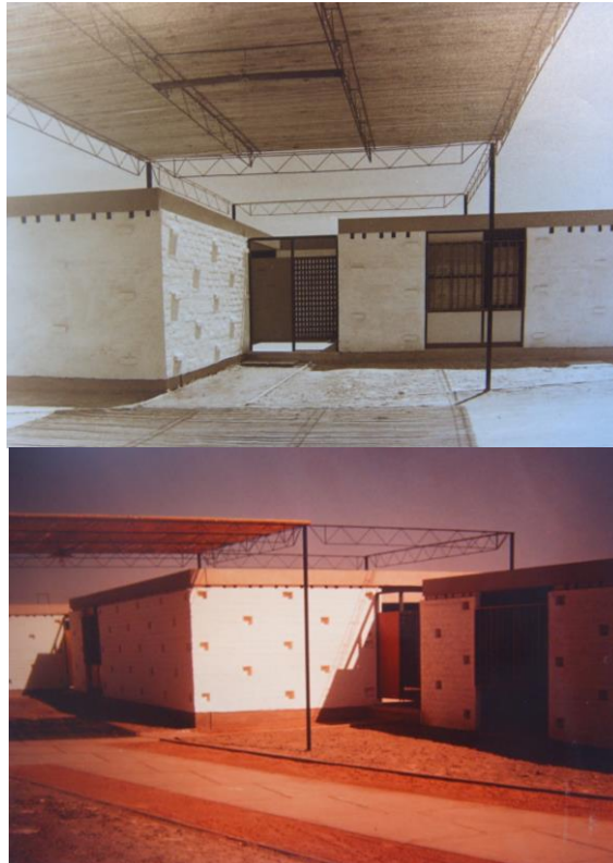
Figura 248: Fotos de accesos desde el exterior a las viviendas Nota: Archivo personal de Héctor Valdés.
