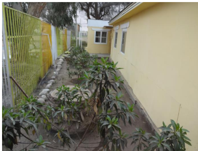
Figura 167: Fotografía antejardín de la fachada Nota: Del autor, 2018.
