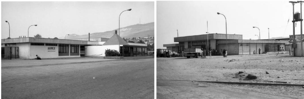
Figura 289: Fotografía Sector restaurante fachada poniente y norte, terminal pesquero de Arica Nota: Archivo personal reinaldo Villanueva.
