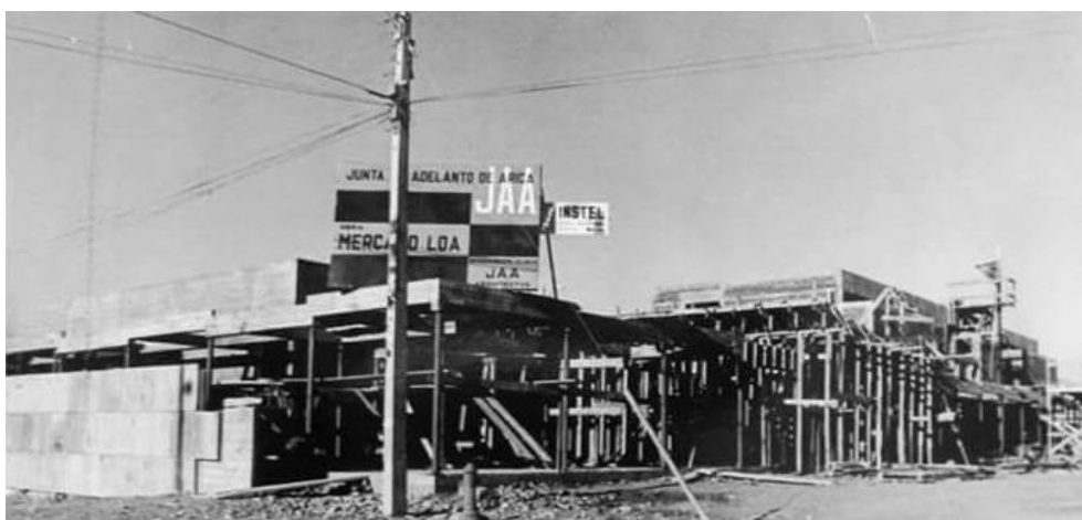
Figura 281: Foto construcción mercado Loa
