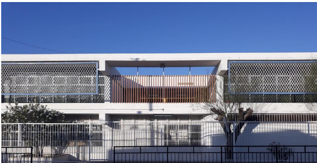
Figura 181: Foto detalle Celosía en fachada principal, 2020 Nota: Del autor.
