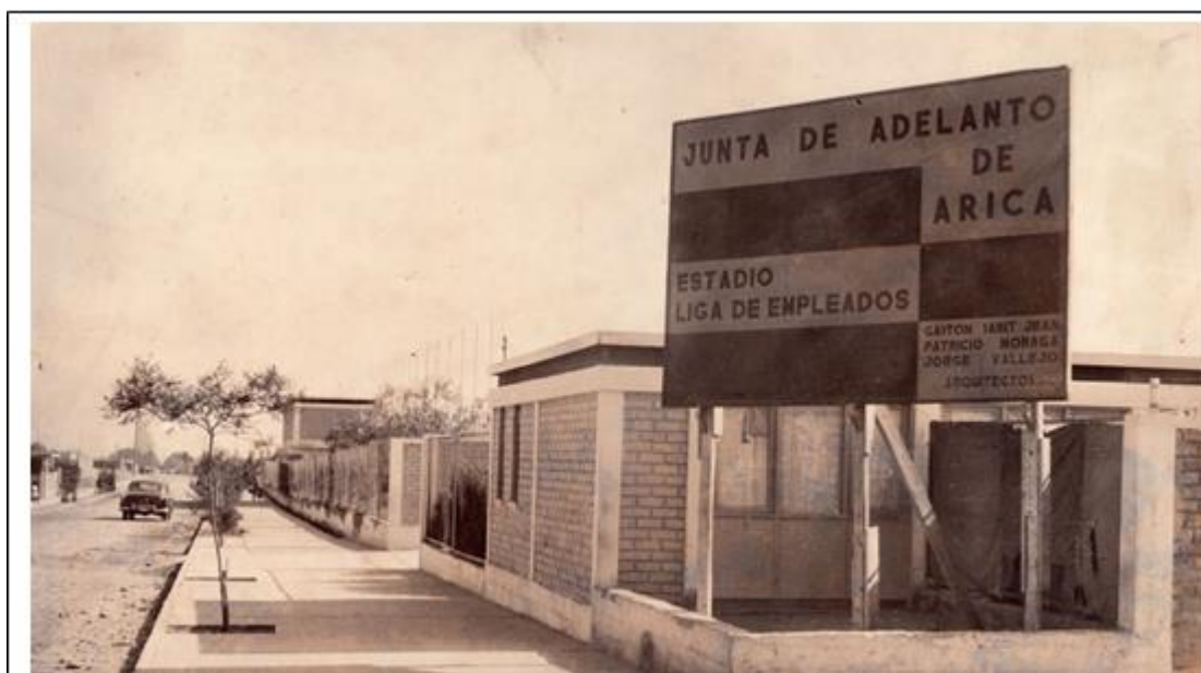
Figura 116: Foto proyecto en construcción Estadio Liga de Empleados Fuente: Archivo Vicente Dagnino.
