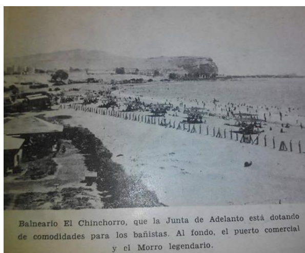
Figura 409: Fotos vistas hacia el sur Nota: Diario la estrella de Arica.
