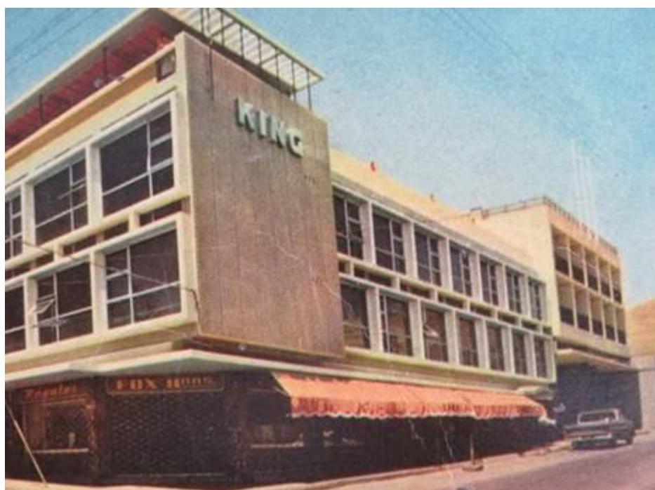
Figura 85: Foto exterior hotel King, fachada Poniente y Norte de manera parcial, año 1962
