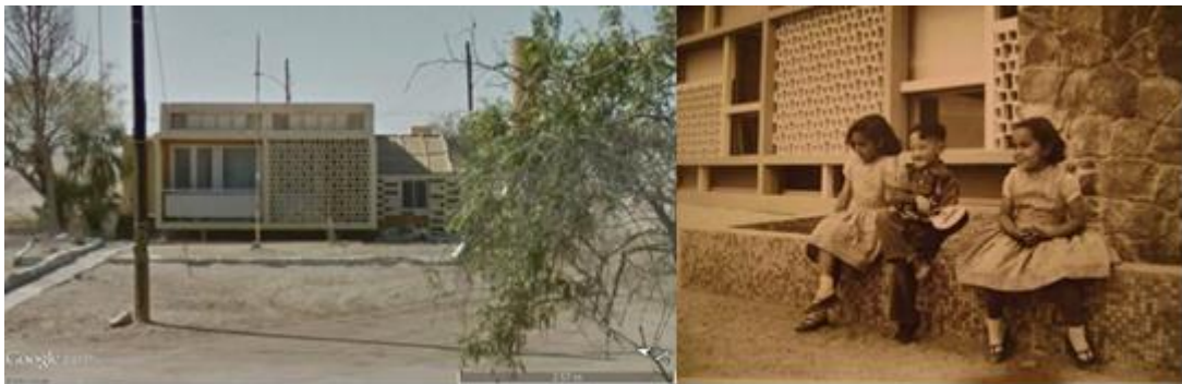
Figura 329: Fotos exteriores de las viviendas del conjunto. Nota: Archivo personal Balby Moran, Google maps.
