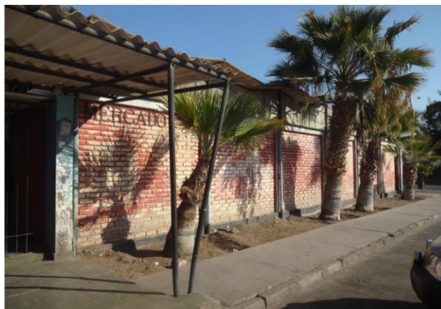
Figura 284: Fotos fachada Poniente Nota: Del autor.
