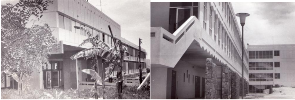
Figura 203: Foto fachada y acceso principal y fachada posterior del bloque principal Nota: Archivo Histórico Vicente Dagnino.
