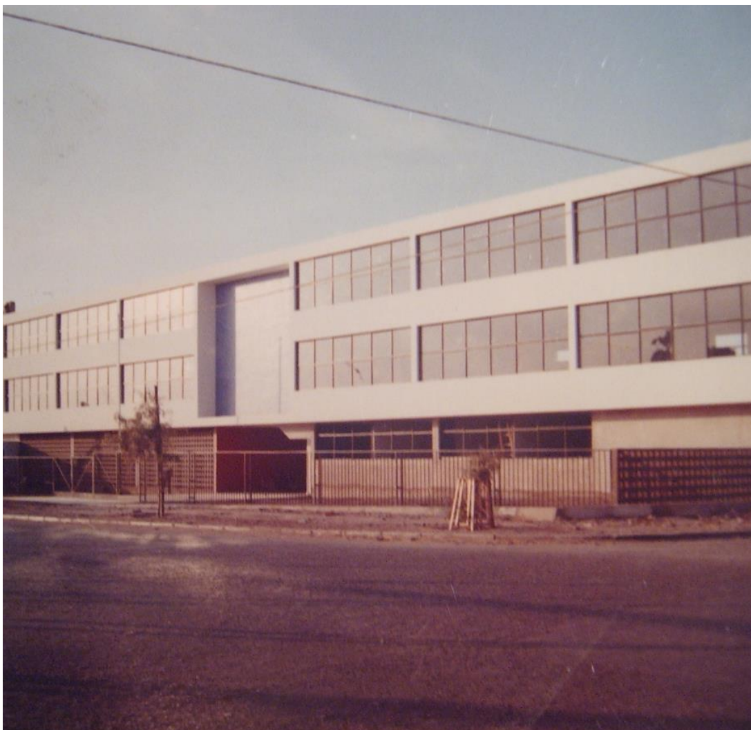
Figura 162: Foto fachada principal, antes de terminadas las obras Nota: Archivo Personal Oscar Macclure Alamos.
