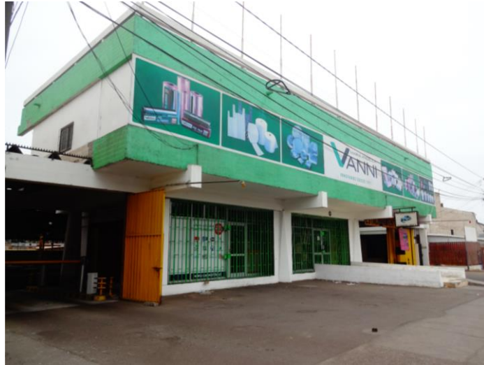
Figura 300: Foto fachada construcción incompleta automóvil club de Chile, sede Arica Nota: Del autor.
