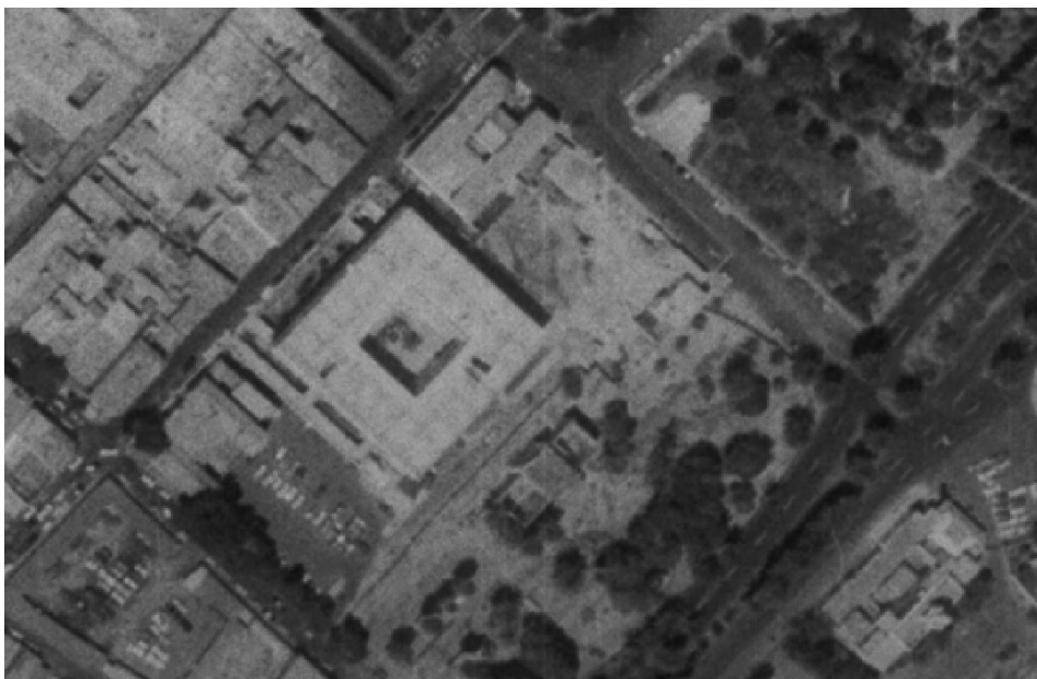
Figura 347: Fotografía aérea 1970 – Edificio de los Servicios Públicos Nota: Servicio Aerofotogramétrico, Vuelo SAF b/n año 1970– Fuerza aérea de Chile.
