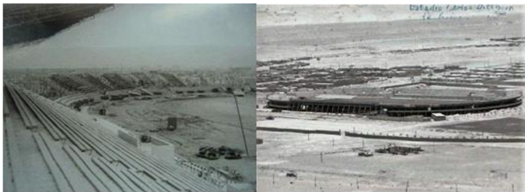
Figura 110: Foto construcción estadio mundialista Nota: Recuperado de Facebook en marzo del 2018.
