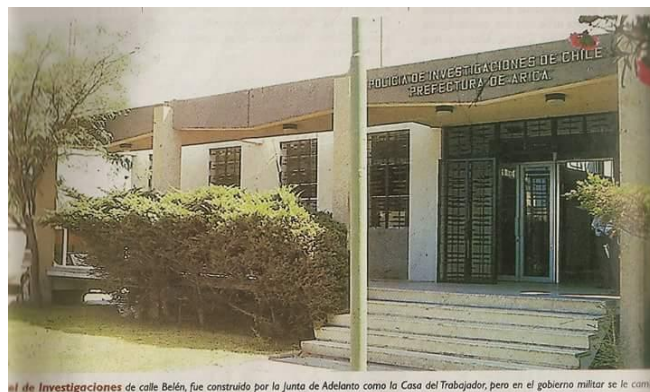
Figura 358: Foto fachada principal, ex casa del trabajador Nota: Archivo personal Balby Moran.
