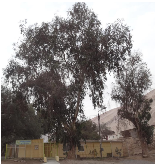
Figura 165: Fotografía de la fachada principal escuela de Molinos Nota: Del autor, 2018.
