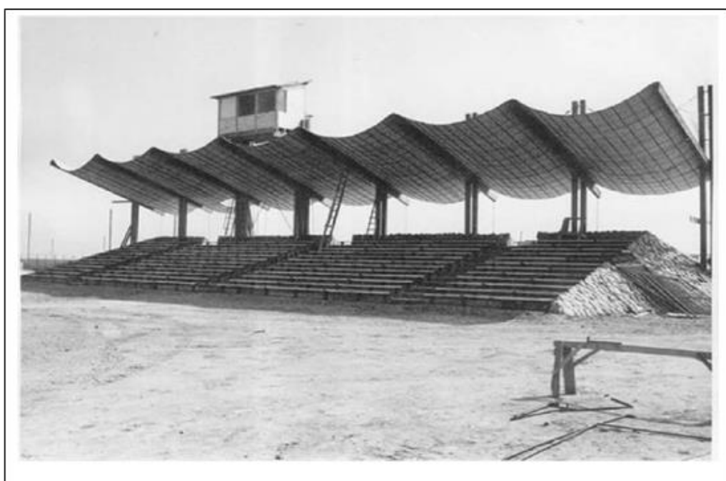
Figura 119: Foto construcción hipódromo Nota: Recuperado de Facebook en marzo del 2018.
