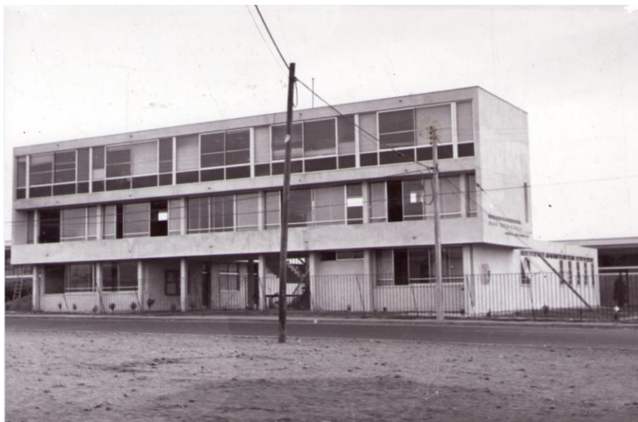
Figura 184: Fotografía fachada exterior Norte Nota: Archivo Histórico Vicente Dagnino.
