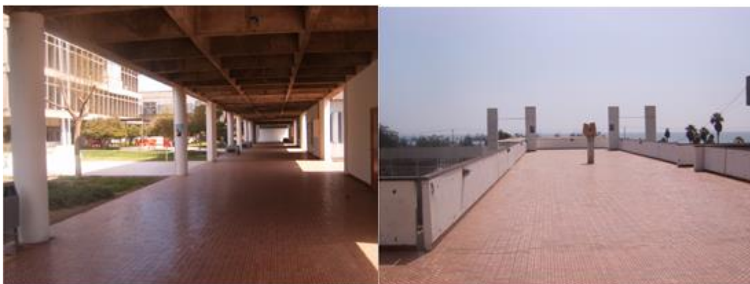
Figura 197: Fotografías espacio público inferior al bloque principal soportado en pilotis y terraza de acceso principal al conjunto
