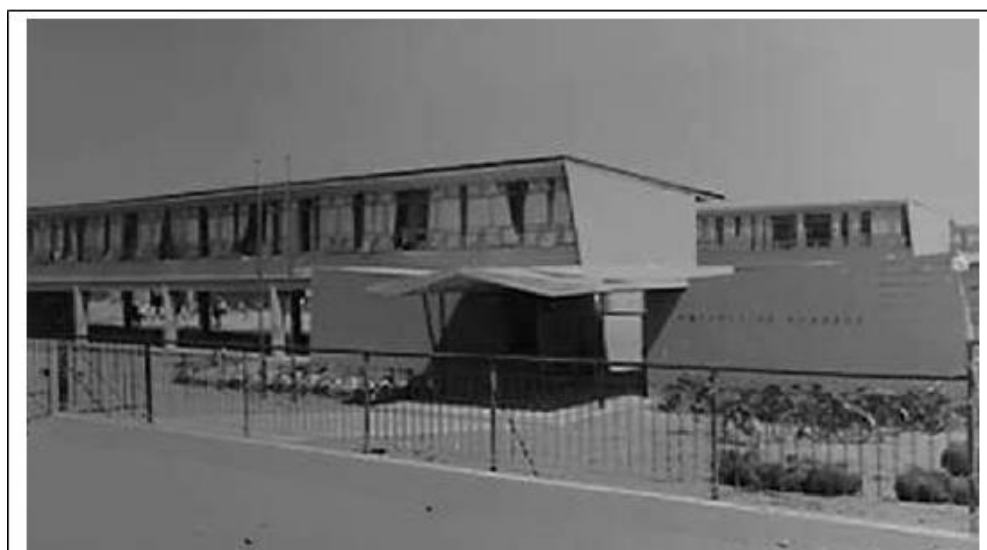
Figura 138: Fachada principal Grupo Escolar el Chinchorro
