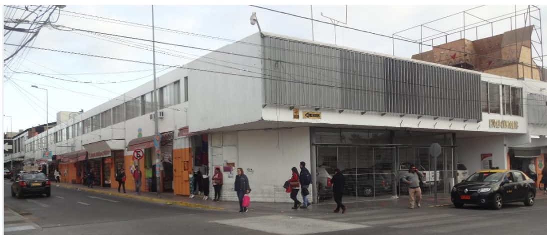
Figura 95: Foto panorámica exterior del edificio, hotel internacional Nota: Archivo personal, 2018.
