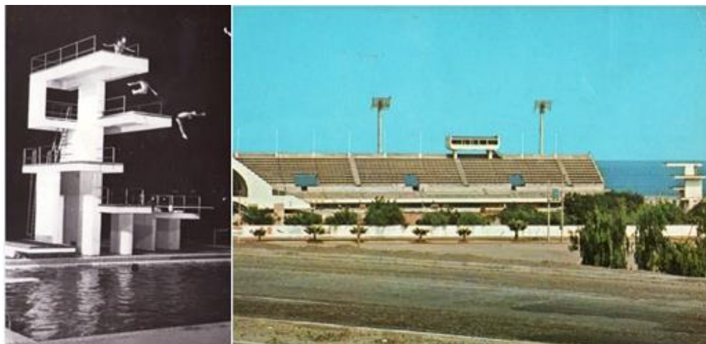
Figura 131: Fotografía plataforma de saltos ornamentales neoplasticista - Fotografía conjunto con terminación de hormigón a la vista
