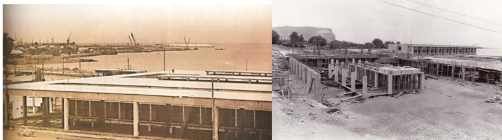
Figura 195: Fotografías construcción del conjunto Nota: Recuperado de Facebook en marzo del 2018.
