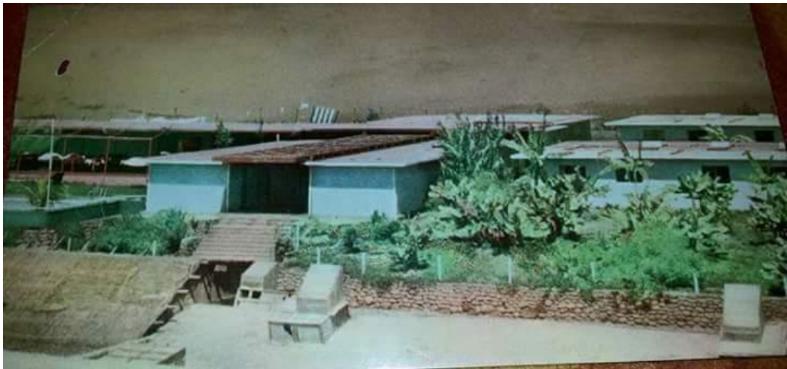
Figura 81: Foto construcción escalera de acceso y muro contrafuerte de 2,70 m. en fachada Nota: Recuperado de Facebook en marzo del 2018.
