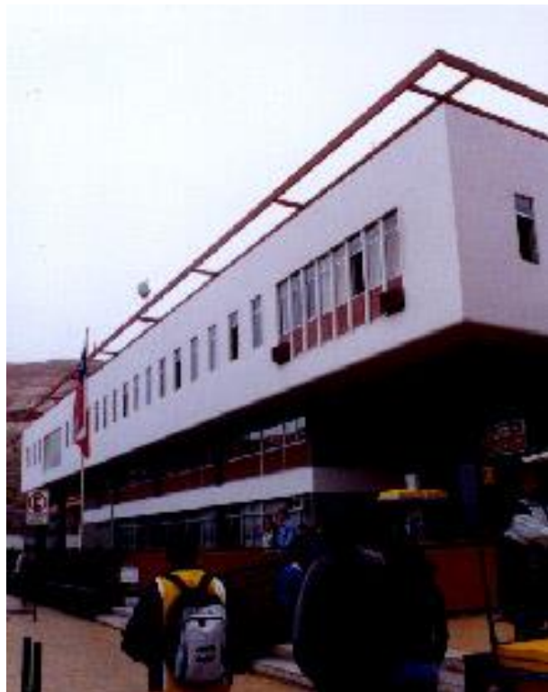
Figura 350: Fotos acceso al conjunto y exterior oriente por calle Prat Nota: Archivo personal Balby Moran.
