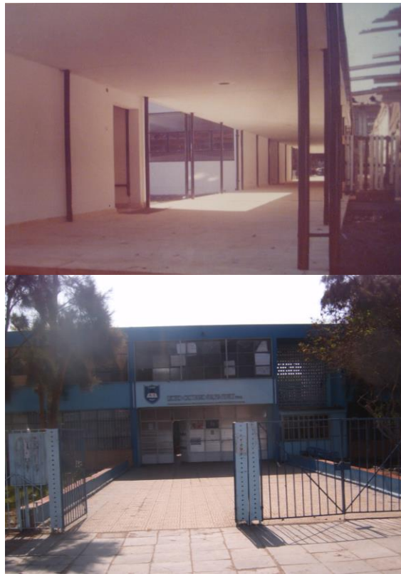
Figura 154: Foto pasillo conector y sector laboratorios y talleres y acceso principal del proyecto Nota: Archivo personal Oscar Macclure, 1961.
