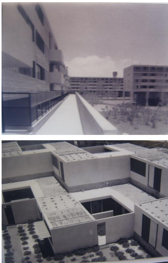
Figura 216: Foto antes de la entrega de obras del conjunto habitacional Estadio, viviendas unifamiliar
