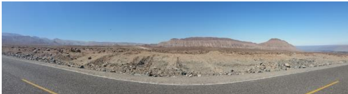
Figura N° 73: Carretera Tacna – Palca con 192.14 ml / Fuente: Google Earth
