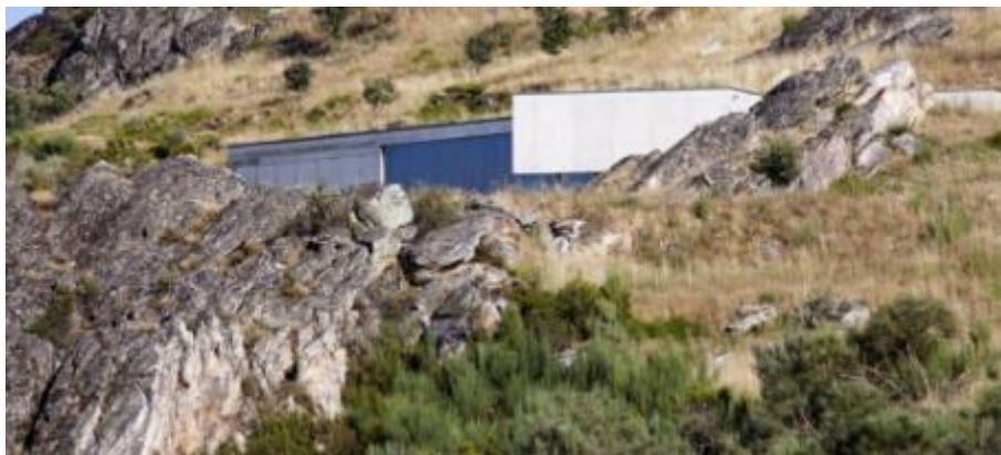
Figura N°10: Acabados Exteriores / Fuente: https://www.archdaily.pe/pe/750275/centro-de-interpretacion-arqueologica-norvia
