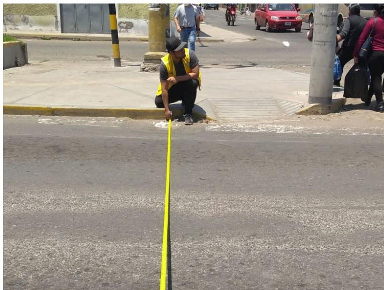
Imagen 9: Se observa las mediciones del ancho de la vía de la Avenida Augusto B. Leguía - Av. Arias y Aragüéz de la intersección III.
