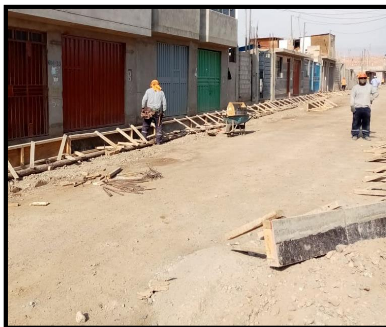
Ilustración 2 Trabajo de desencofrado
