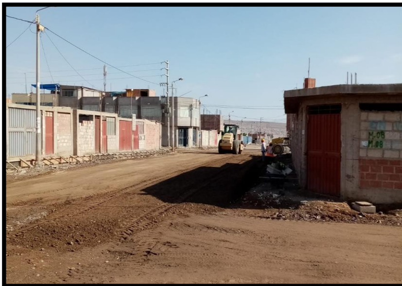
Ilustración 8 Compactado de la Base
