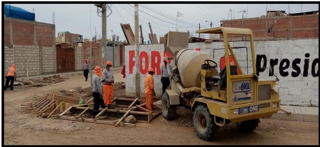
Ilustración 10 Mezclando concreto para el vaciado de vereda.
