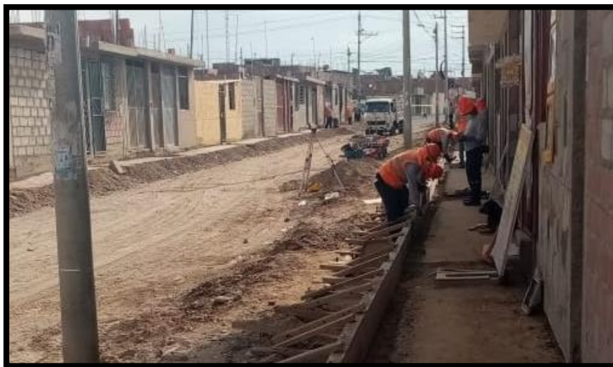
Ilustración 1 Trabajo de encofrado
