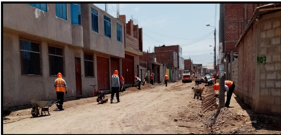
Ilustración 9 Terraplén de vereda
