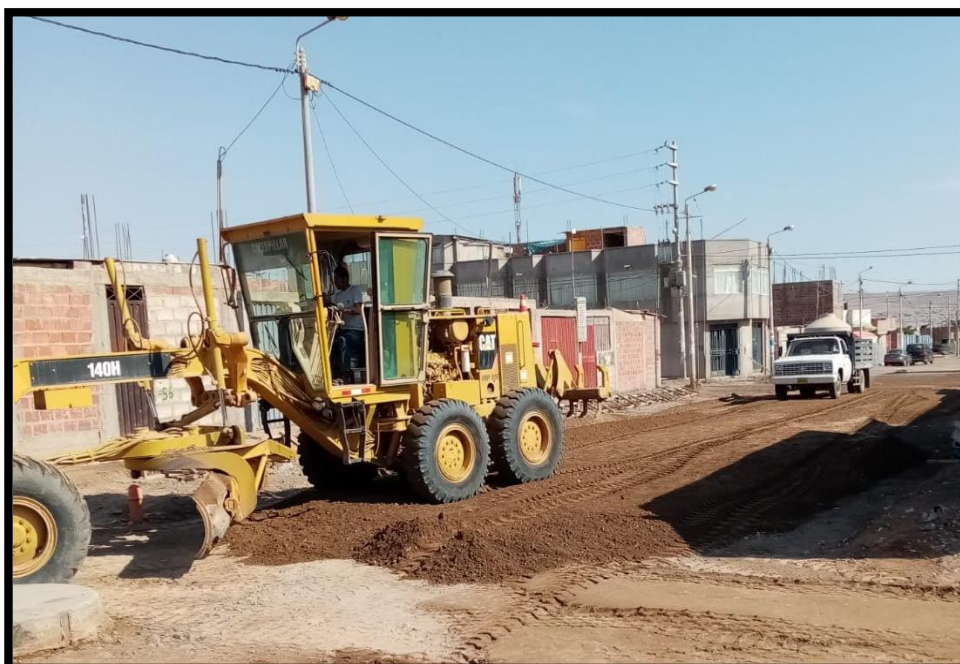
Ilustración 7 Nivelación, esparcido y humedecimiento de la base
