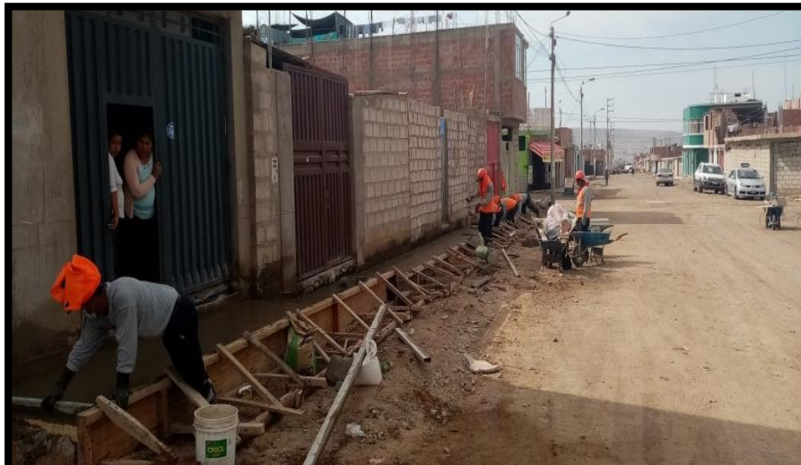
Ilustración 3 Vaciado de concreto en vereda
