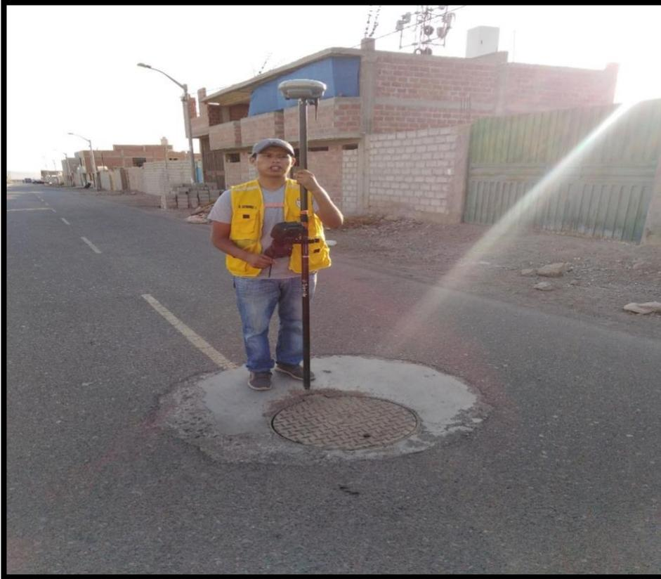
**Fotografía 15: Levantamiento topográfico con GPS Diferencial.**
