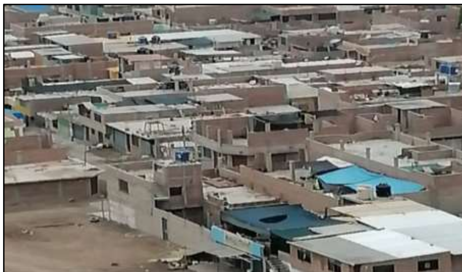
Figura 66. Construcción de viviendas en Zona de Riesgo
