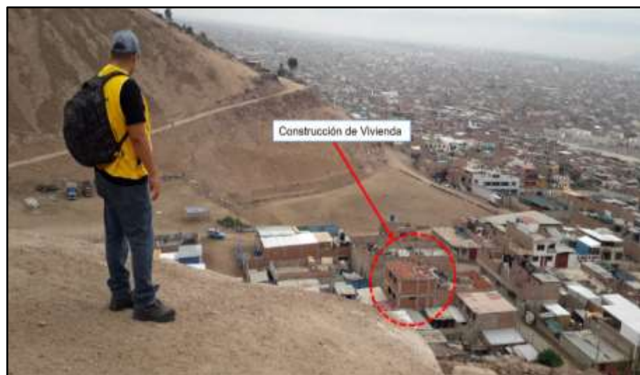
Figura 25. Construcción de viviendas en Zona de Peligro
