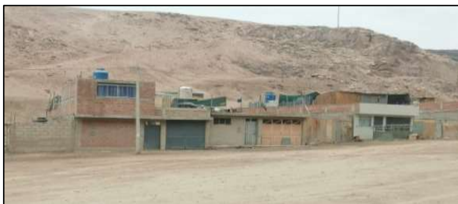
Figura 41. Edificaciones en ladera - Quebrada del Diablo
