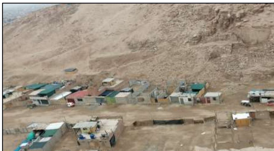
Figura 64. Viviendas Autoconstruidas sin apoyo técnico – AA.HH. El Mirador
