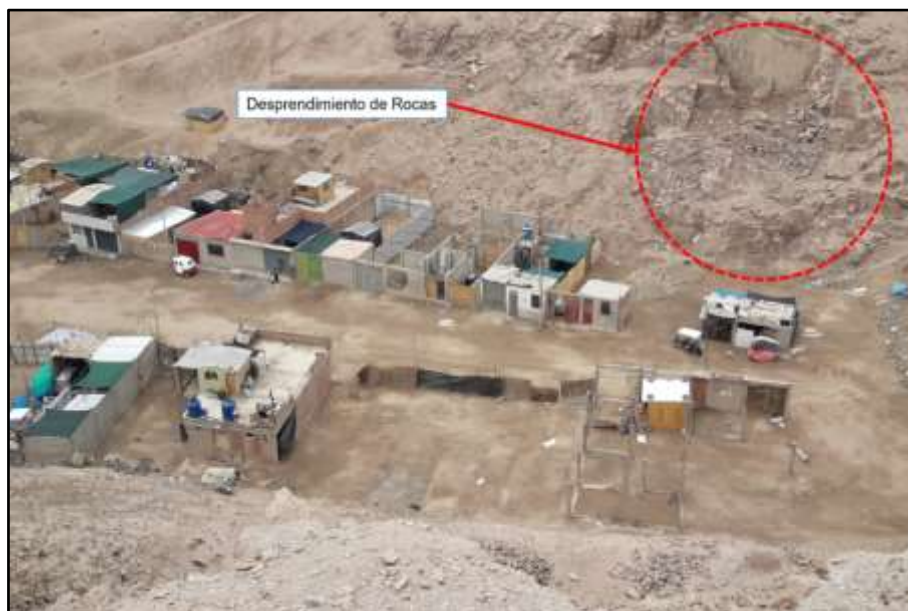
Figura 29. Desprendimiento de Rocas el AA.HH. El Mirador
