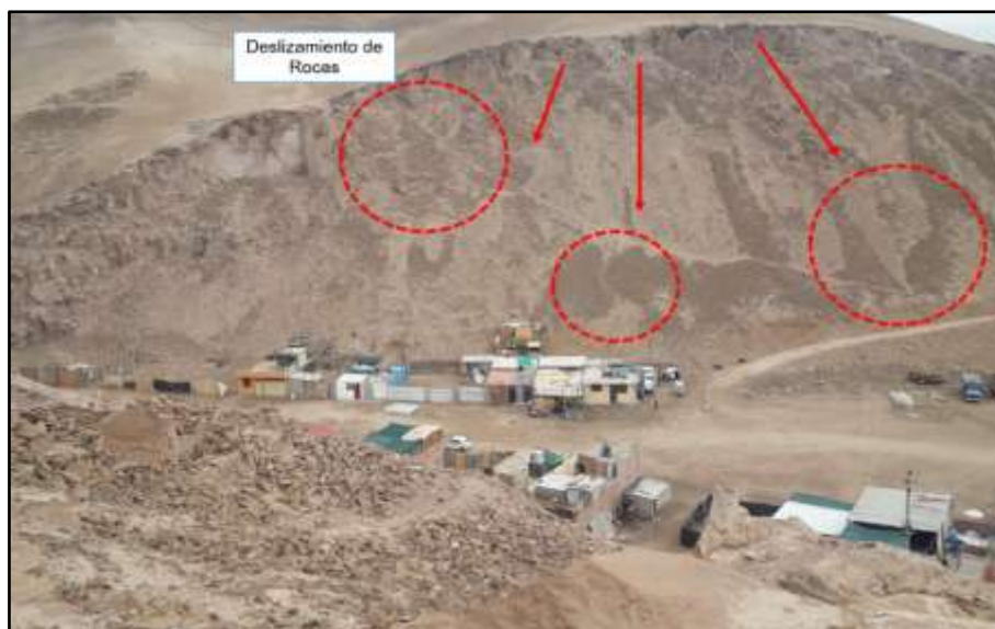
Figura 30. Deslizamiento de Rocas en la AA.HH. El Mirador
