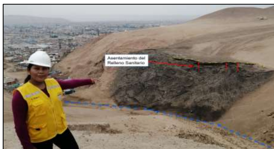
Figura 27. Vista del Asentamiento del Relleno Sanitario
