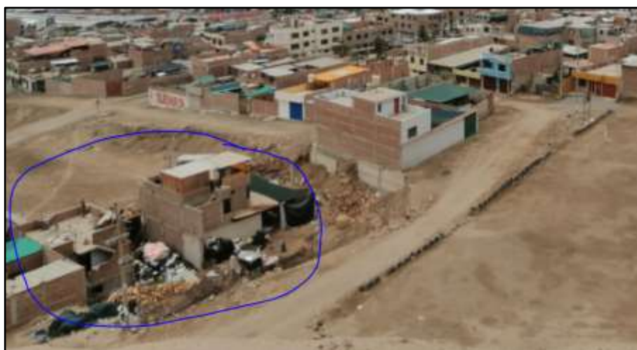
Figura 39. Edificaciones Sobre Relleno - Asoc. San Pedro
