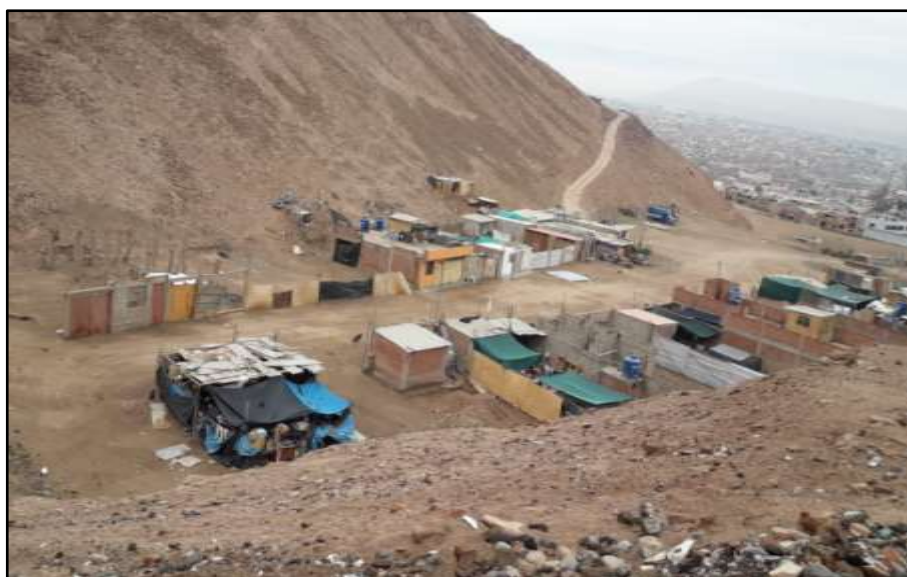
Figura 43. Edificaciones precarias en plena desembocadura
