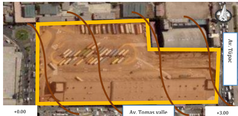
Figura 26. Desnivel topográfico Terminal Terrestres Plaza Norte. Fuente: Elaboración Propia
