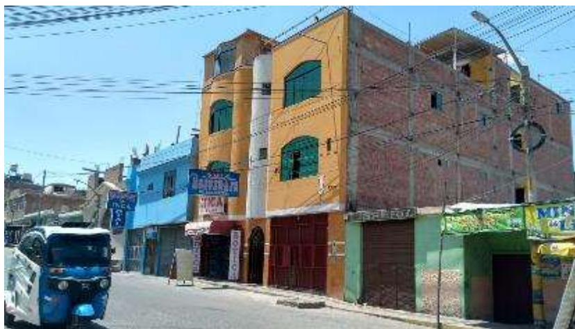
Figura 73. Estado de edificación – Av. Emancipación
