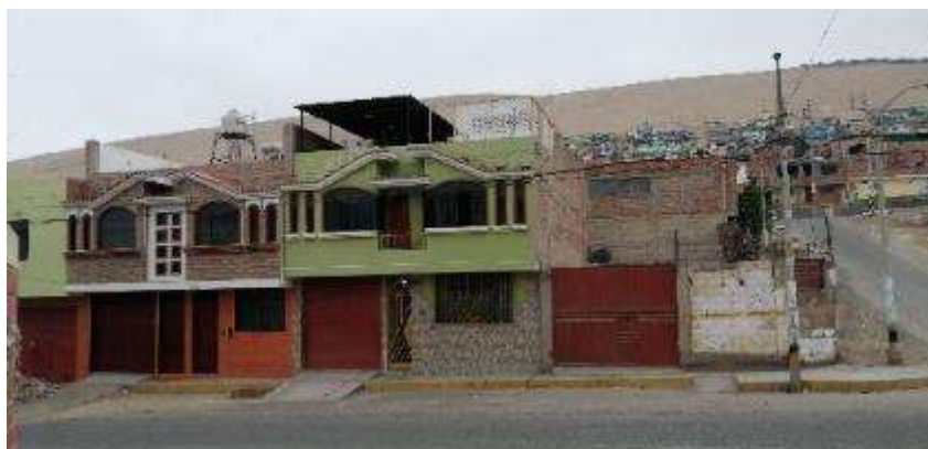
Figura 74. Estado de edificación – Av. Gregorio Albarracín
