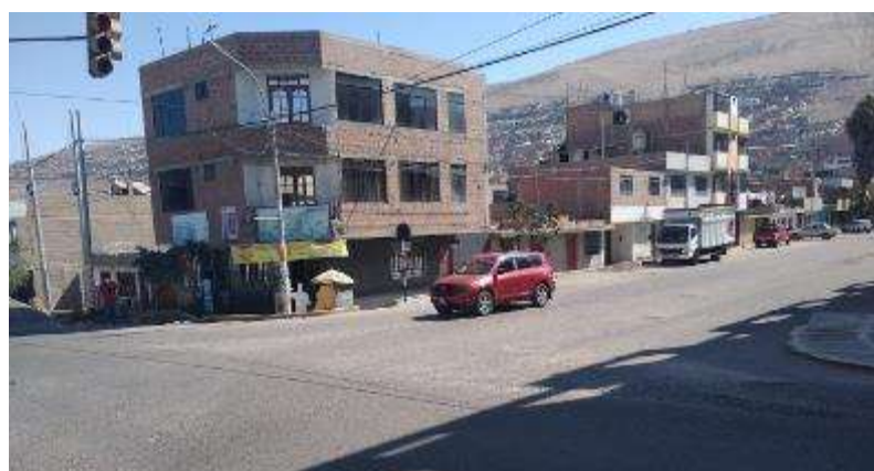
Figura 76. Estado de edificación – Calle Haití.
