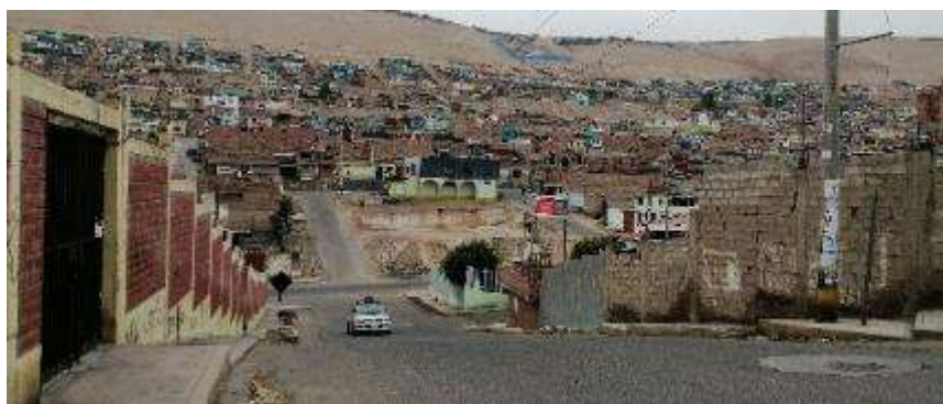
Figura 75. Estado de edificación – Calle Luis Sánchez Cerro.
