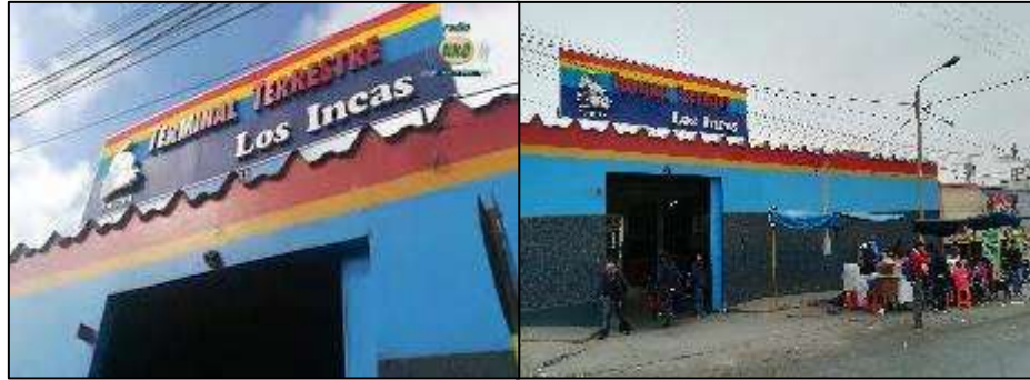
Figura 3. Terminal Terrestre Los Incas – Ingreso principal
