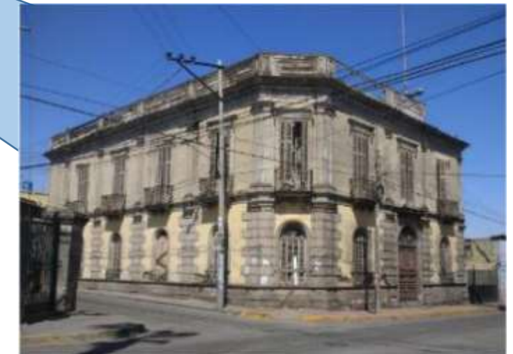
CASONA ABANDONADA Y DETERIORADA
