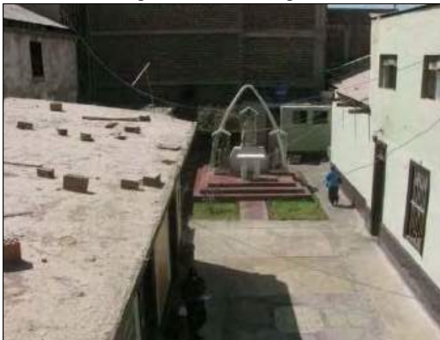
Figura N°22: Patio de Ingreso
