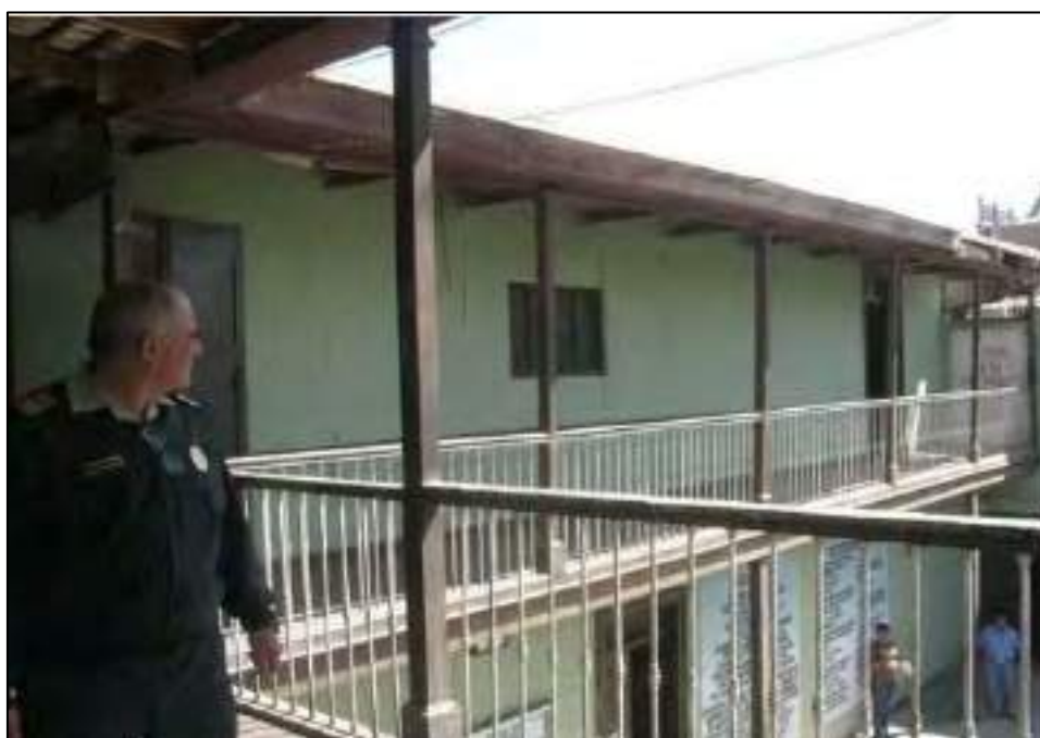
Figura N°23: Pasillo del Segundo Piso
