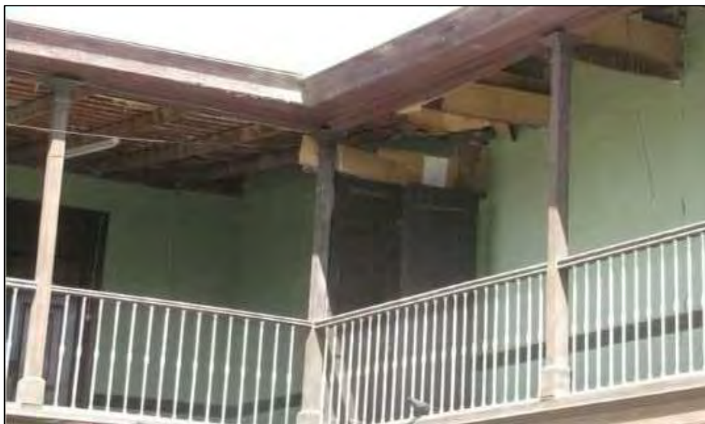
Figura N°20: Pasillo del Segundo Piso
