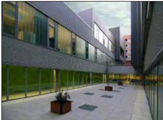
Figura N°7: Patio Interno del Edificio de la Guardia de Lleida
