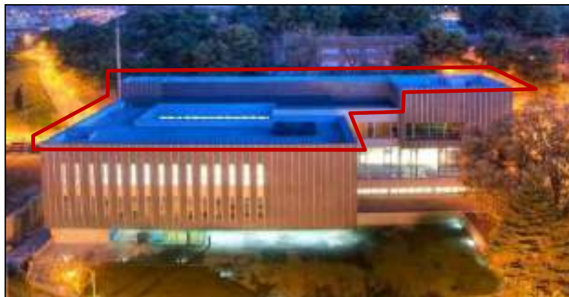
Figura N°6: Cubierta del Edificio de la Guardia de Lleida
