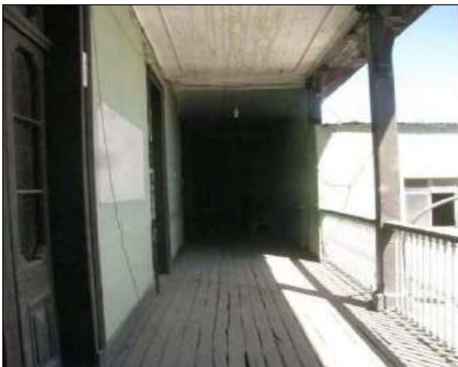
Figura N°21: Ingreso al Pasillo del Segundo Piso
