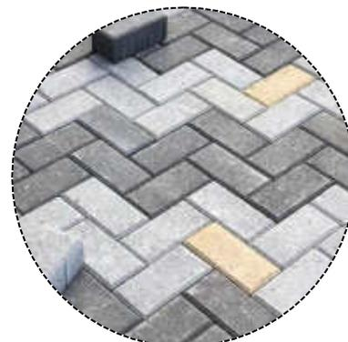
Figura 272. Piso adoquines de concreto
