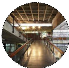
Figura 260. Sistema de losa gofre expuesto.
