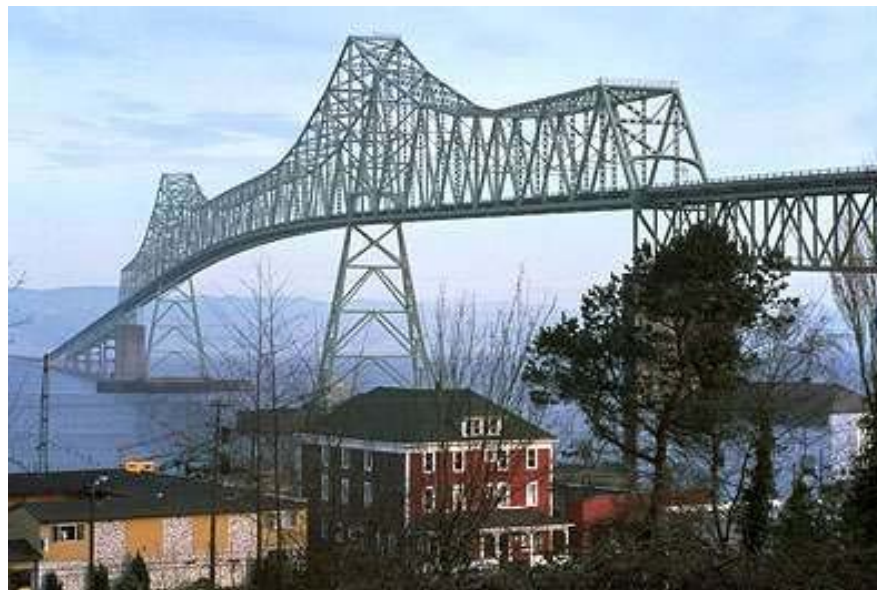
Figura 6. Astoria Bridge (1966), Columbia River in Oregon, U.S., puente continuo de 3 tramos, tramo central de 370. Fuente: Enciclopedia Británica
