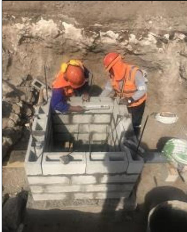
*Fotografía 3. Instalación de buzones de inspección.*
