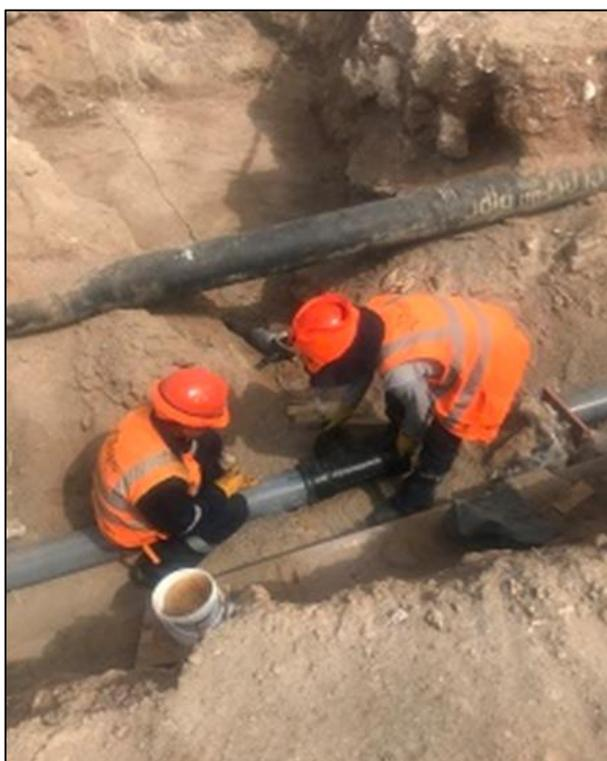
*Fotografía 2. Colocación de unión entre tuberías.*
