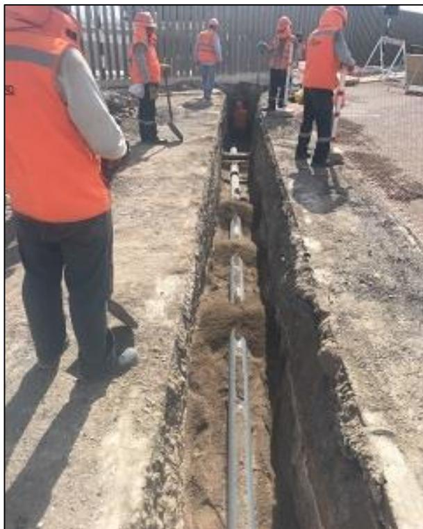
*Fotografía 4. Instalación de la tubería de PVC de 4”.*
