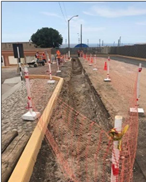
*Fotografía 1. Excavación de zanja.*
