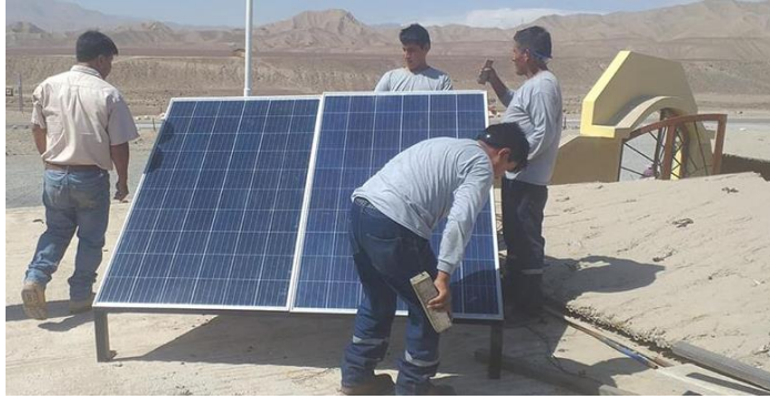
Figura 57: Paneles solares en el Complejo Arqueológico de Miculla Fuente: Gobierno Regional de Tacna
