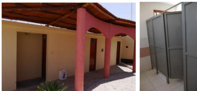
Figura 76: Vista de los servicios higiénicos (Fotografía: Visita a campo)
