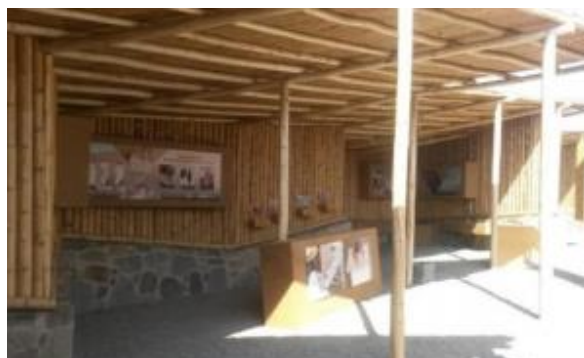
Figura 14: Vista interior del Centro de Interpretación Caral
