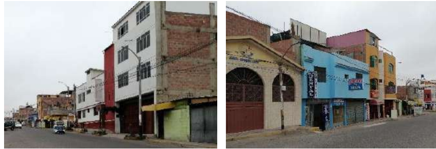
Figura 23: Estado de edificación de las viviendas en la Av. Emancipación. Fuente: Elaboración propia.
