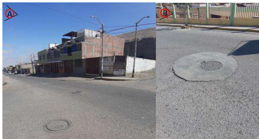
Figura 38: Buzones de alcantarillado en los alrededores. Fuente: Elaboración propia.
