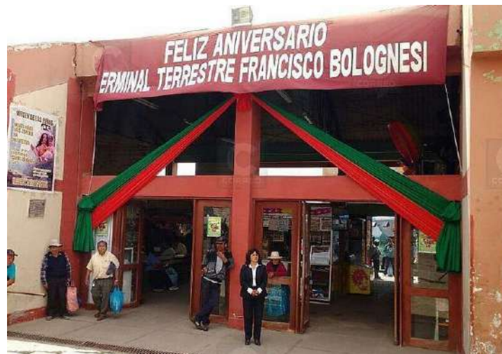
Figura 6: Terminal Terrestre Bolognesi Fuente: Google Images.
