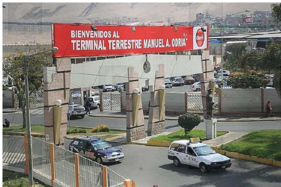
Figura 4: Terminal terrestre Manuel A. Odría en Tacna. Fuente: Google Images.
