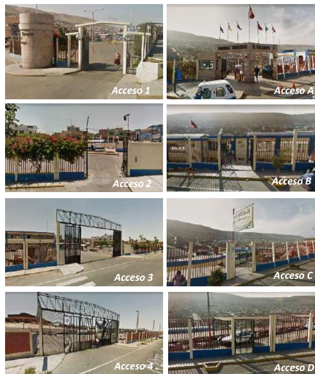
Figura 30: Accesos a la edificación existente. Fuente: Elaboración propia.
