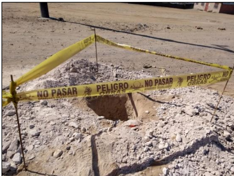
Figura 15. Excavación de calicata C-4, y toma de muestra en la sub rasante. Fuente Elaboración Propia
