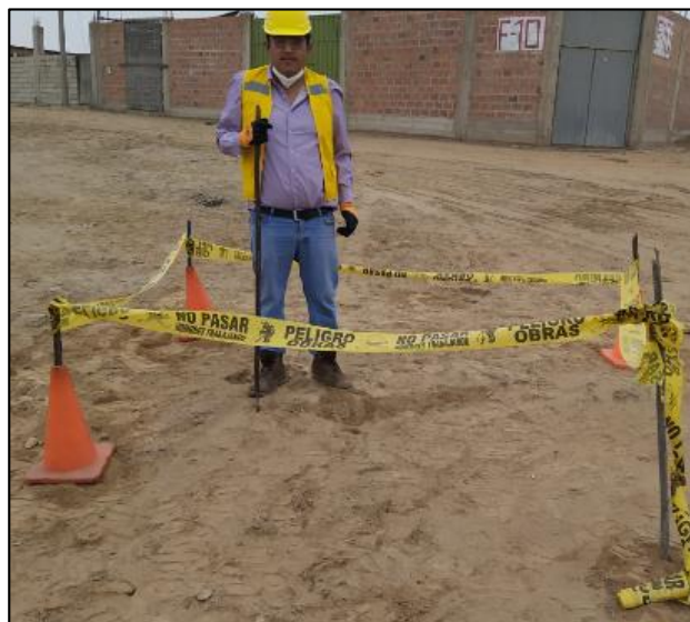
Figura 17. Excavación de calicata C-7, y toma de muestra en la sub rasante. Fuente Elaboración Propia
