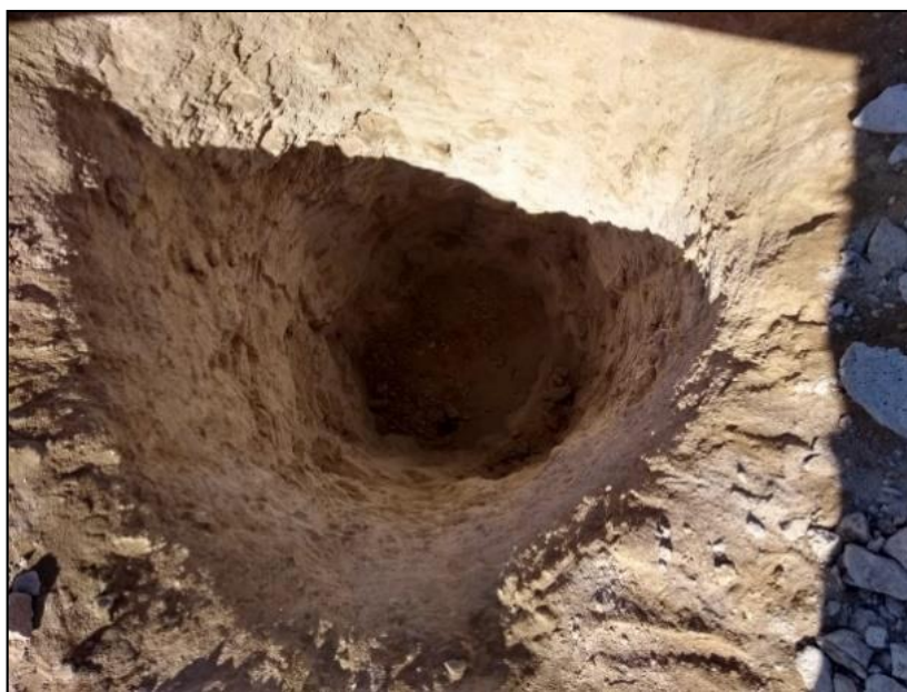
Figura 18. Excavación de calicata C-8, y toma de muestra en la sub rasante. Fuente Elaboración Propia
