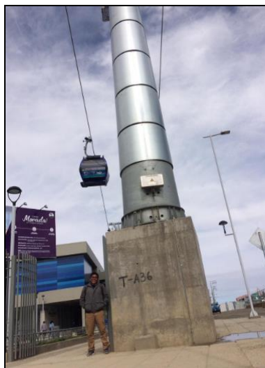
Figura 29. Vista de base de torre de soporte.
