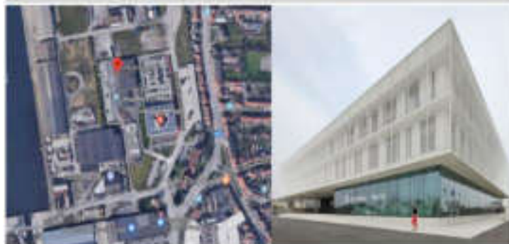
Figura 74: Datos generales de la estación de la policía Brugge
