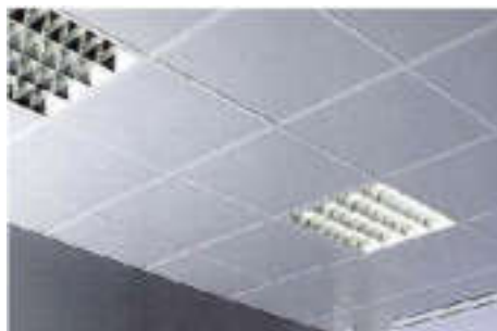
Figura 37: Falso techo de metal 2
