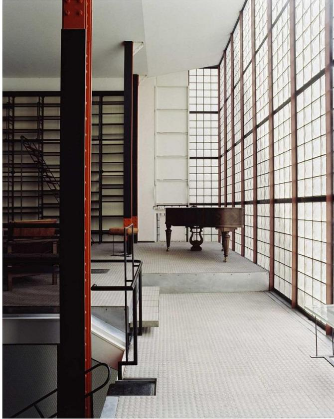
Figura 7. Luz difusa al interior de la casa de cristal, lograda con los adoquines de vidrio
