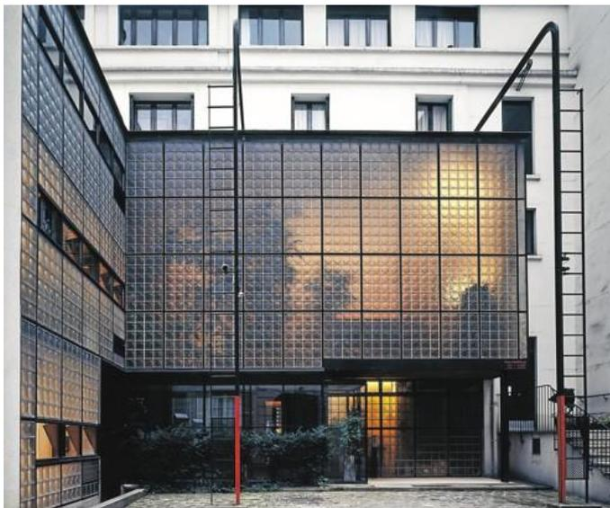
Figura 6. Fachada compuesta por adoquines de vidrio en la Casa de Cristal
