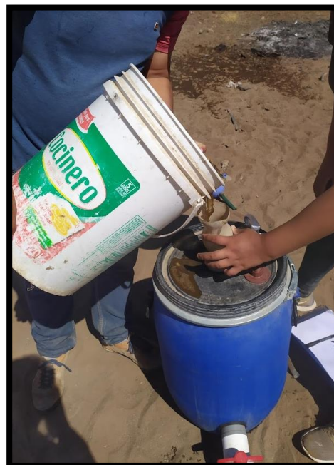
Fotografía N° 09: Recarga de los biodigestores
