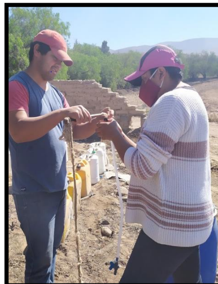
Fotografía N° 04: Implementación de la manguera plástica al bidón Fuente: elaboración propia
