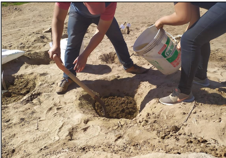
Fotografía N° 05: Excavación de suelo Fuente: Elaboración propia
