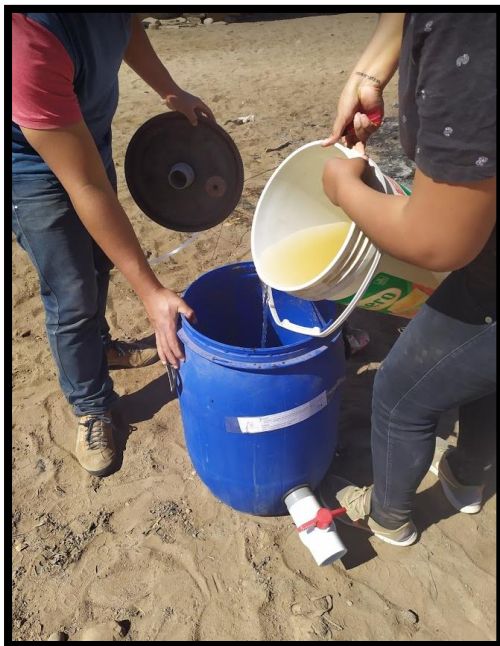
Fotografía N° 06: Llenado de los biodigestores Fuente: elaboración propia
