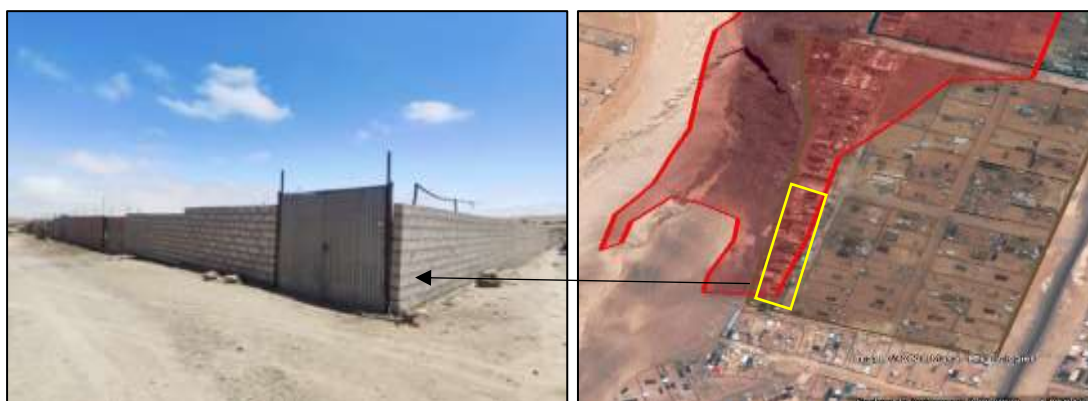
FIGURA N° 105. Vista lateral de la Manzana “H” de Asoc. la Cruz Divina
