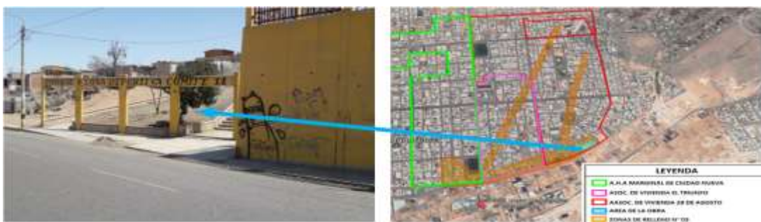
FIGURA N° 228. No presenta fisuras y grietas en el parque y losa deportiva comité 11
