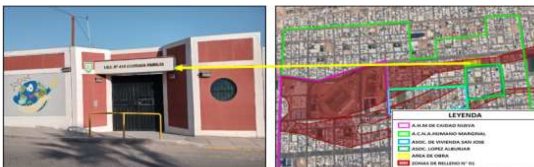
FIGURA N° 212. No presenta fisuras y grietas en la I.E.I N° Sagrada Familia
