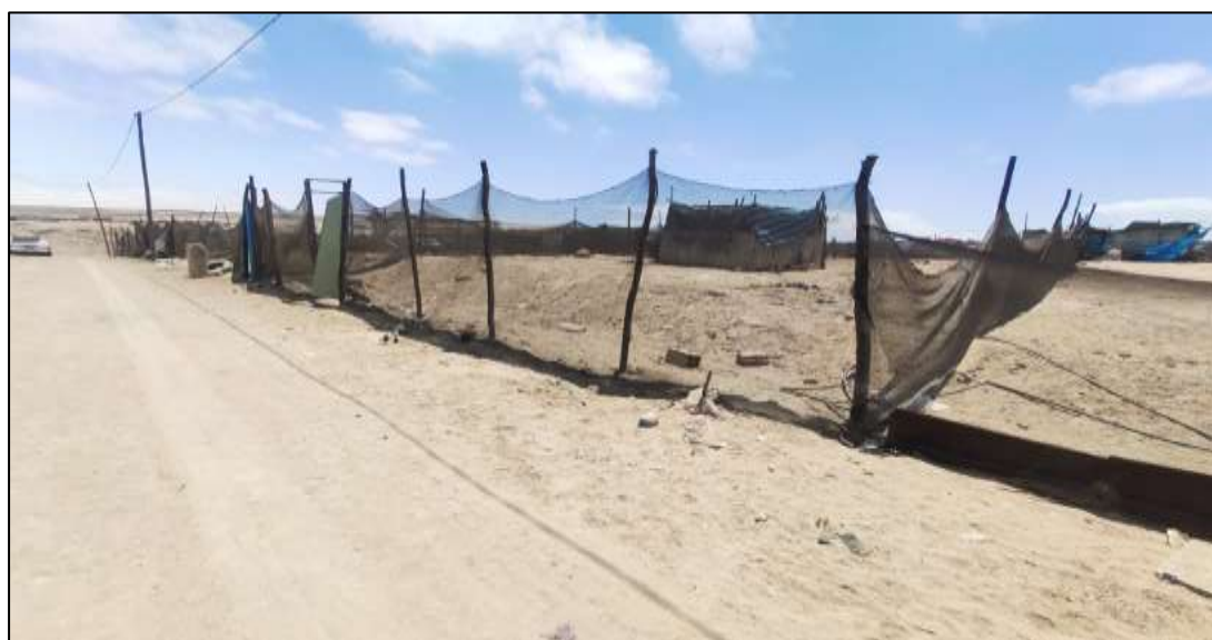
FIGURA N° 101. Cercos improvisados en predios de la Manzana “D” de la Asoc. de Criadores de Aves Alto Santa Cruz
