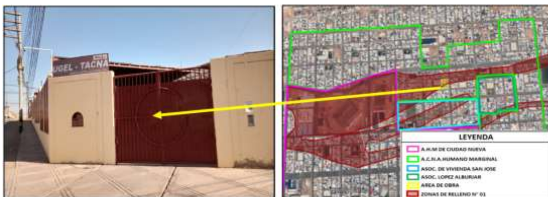
FIGURA N° 211. No presenta fisuras y grietas en el complejo Unidad de Gestión Educativa “UGEL” – TACNA
