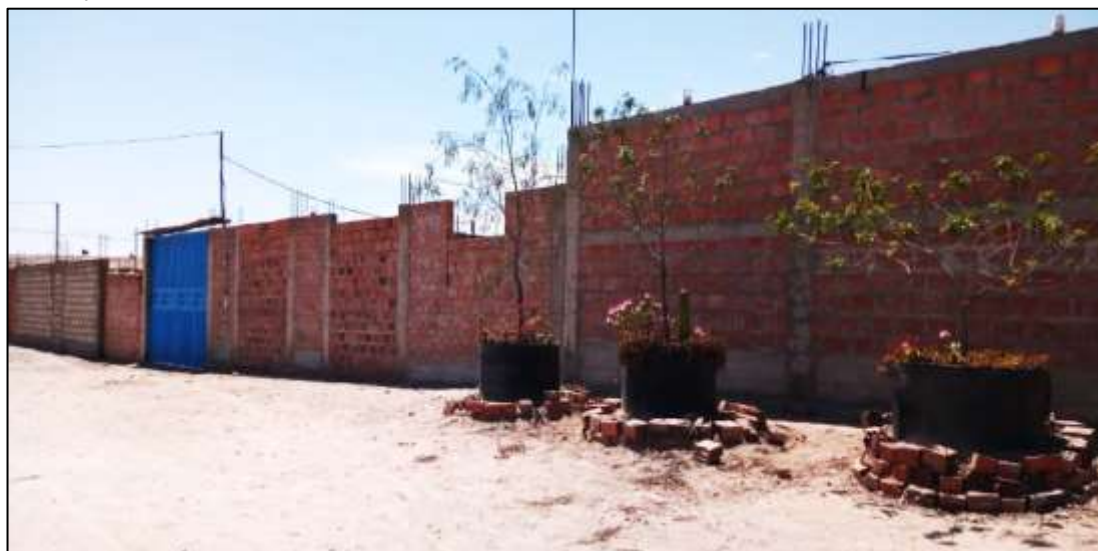
FIGURA N° 117. Ausencia de fisuras en cercos perimétricos de ladrillos en la Mz. F de la Asoc. Artesanal Taller de Vivienda de Héroes Alto de Alianza.
