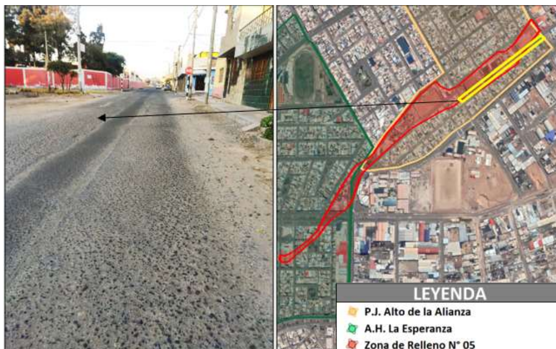
FIGURA N° 168. Presencia de resanes en carpeta asfáltica en la Av. Aviación y ubicación satelital
