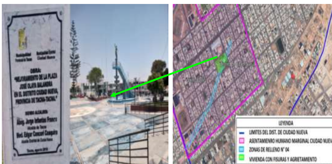
FIGURA N° 235. No presenta fisuras la Plaza José Olaya Balandra y Ubicación Satelital
