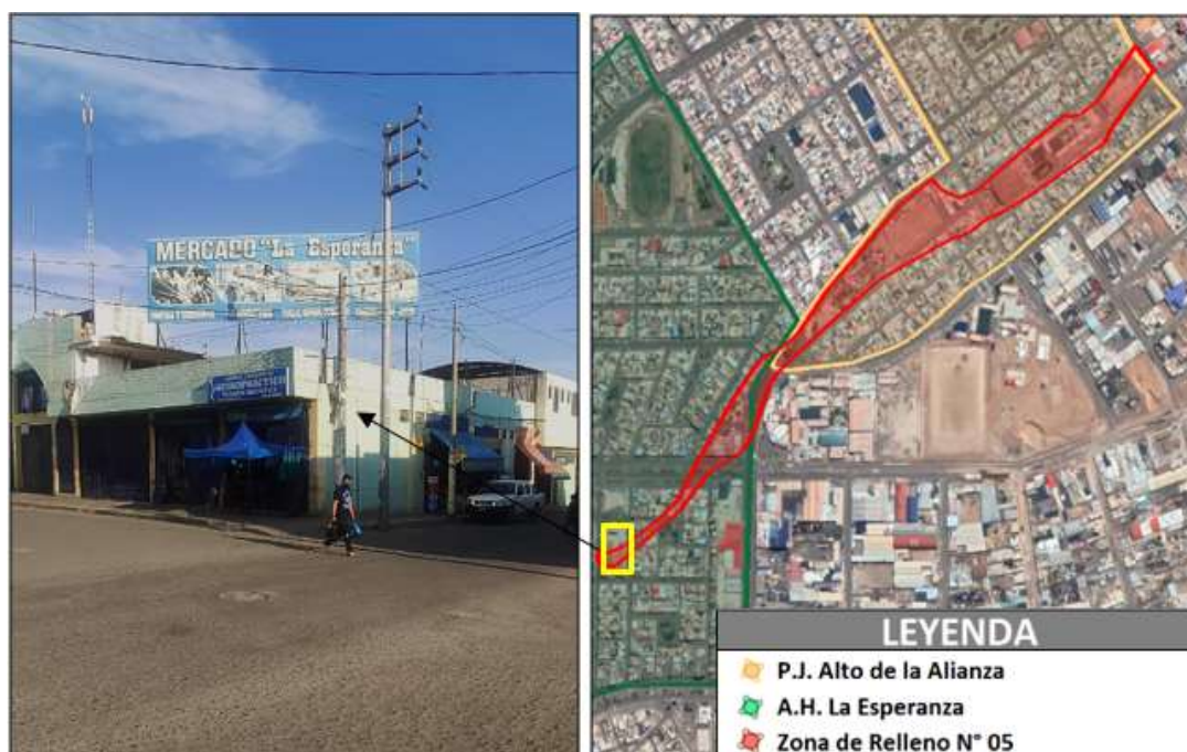
FIGURA N° 160. Fachada de ingreso al Mercado La Esperanza y ubicación satelital
