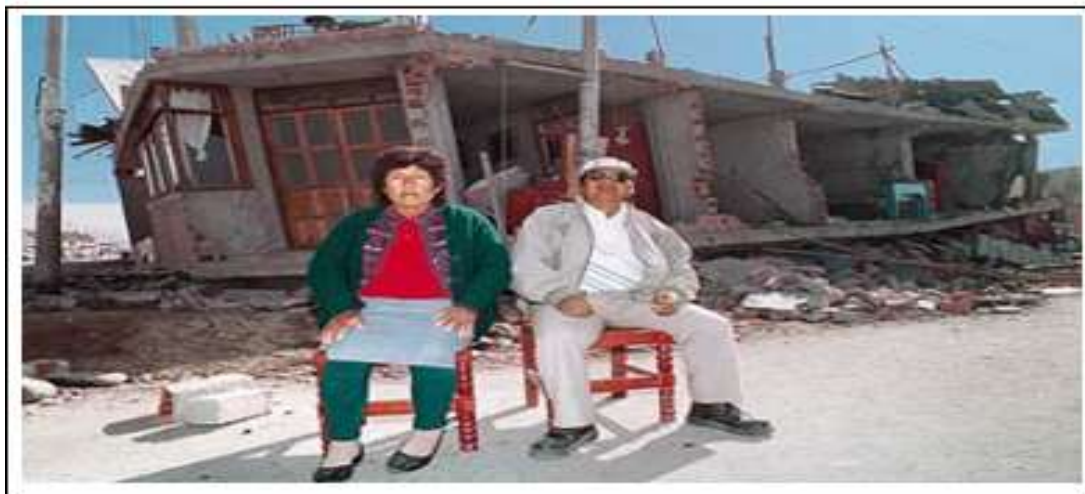
FIGURA N° 7. Terremoto de Tacna 23 de junio del 2001, daños en edificaciones construidas sobre rellenos en el Distrito Alto de la Alianza.
