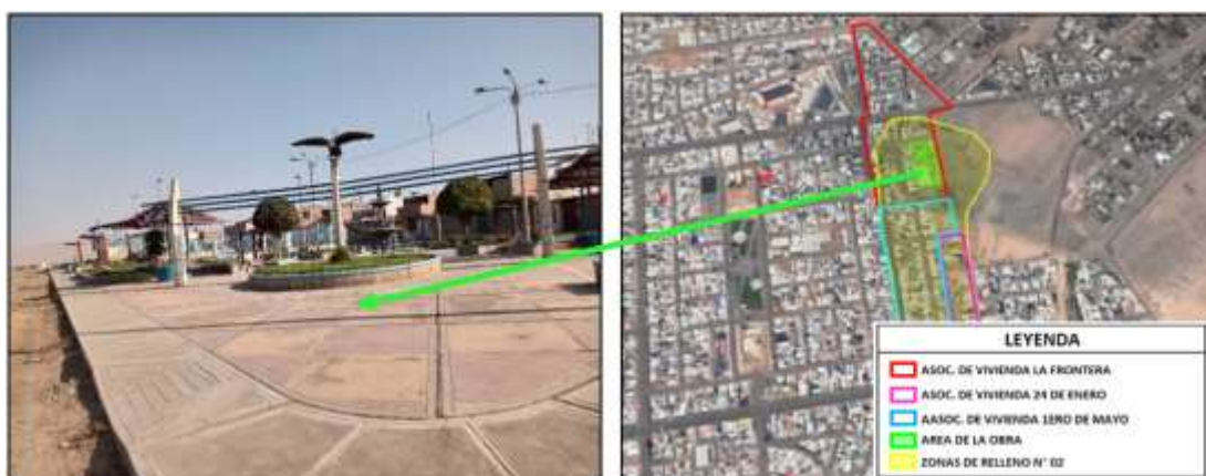
FIGURA N° 217. Plaza y losa deportiva de la Asociación de Vivienda la Frontera y Ubicación satelital
