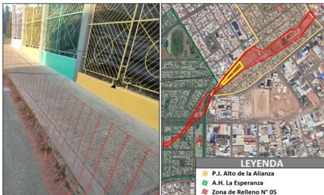
FIGURA N° 159. Cerco perimétrico del Parque de la Familia en buen estado de conservación y ubicación
