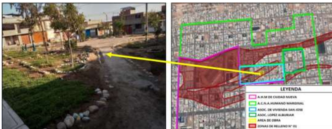
FIGURA N° 189. No presenta fisuras y grietas en la Plaza Cívica San José
