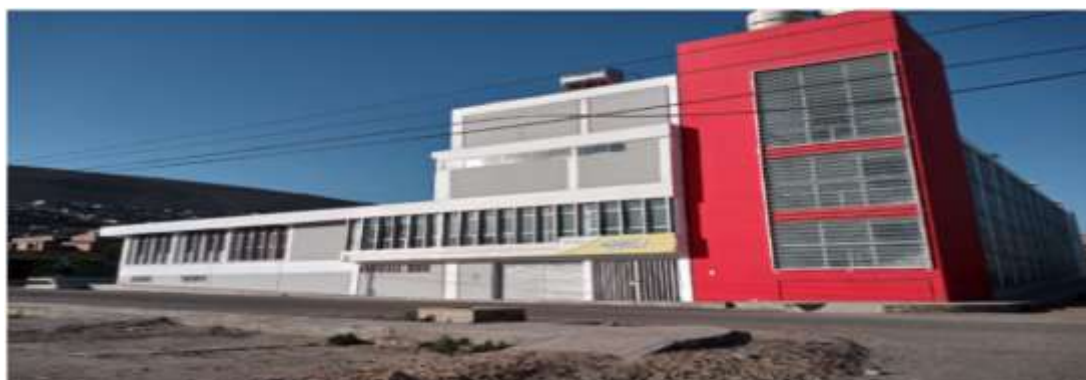
FIGURA N° 214. No presenta fisuras en el Local para personas Altamente Vulnerables
