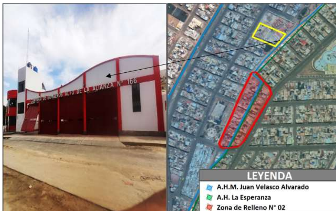
FIGURA N° 134. Fachada de ingreso a la Compañía de Bomberos N° 166 y ubicación satelital
