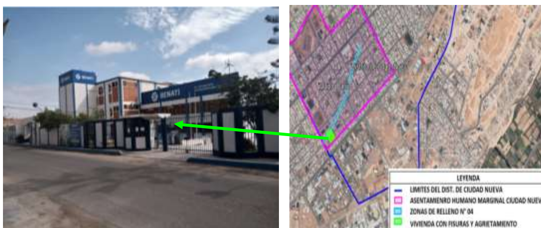
FIGURA N° 231. No presenta fisuras ni grietas en el Instituto Técnico Senati y Ubicación Satelital
