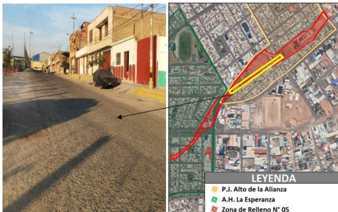
FIGURA N° 166. Infraestructura vial de la Calle 27 de agosto
