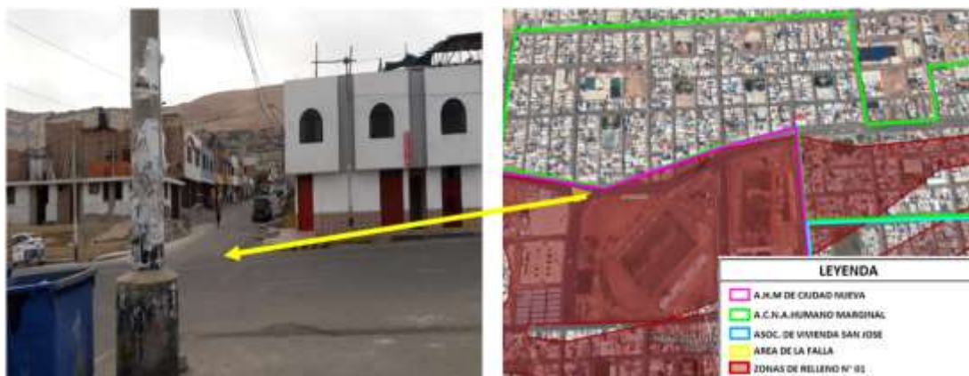
FIGURA N° 200. Infraestructura vial de la Av. Mariano Necochea y ubicación Satelital Fuente: Visita a campo 29 de setiembre de 2020
