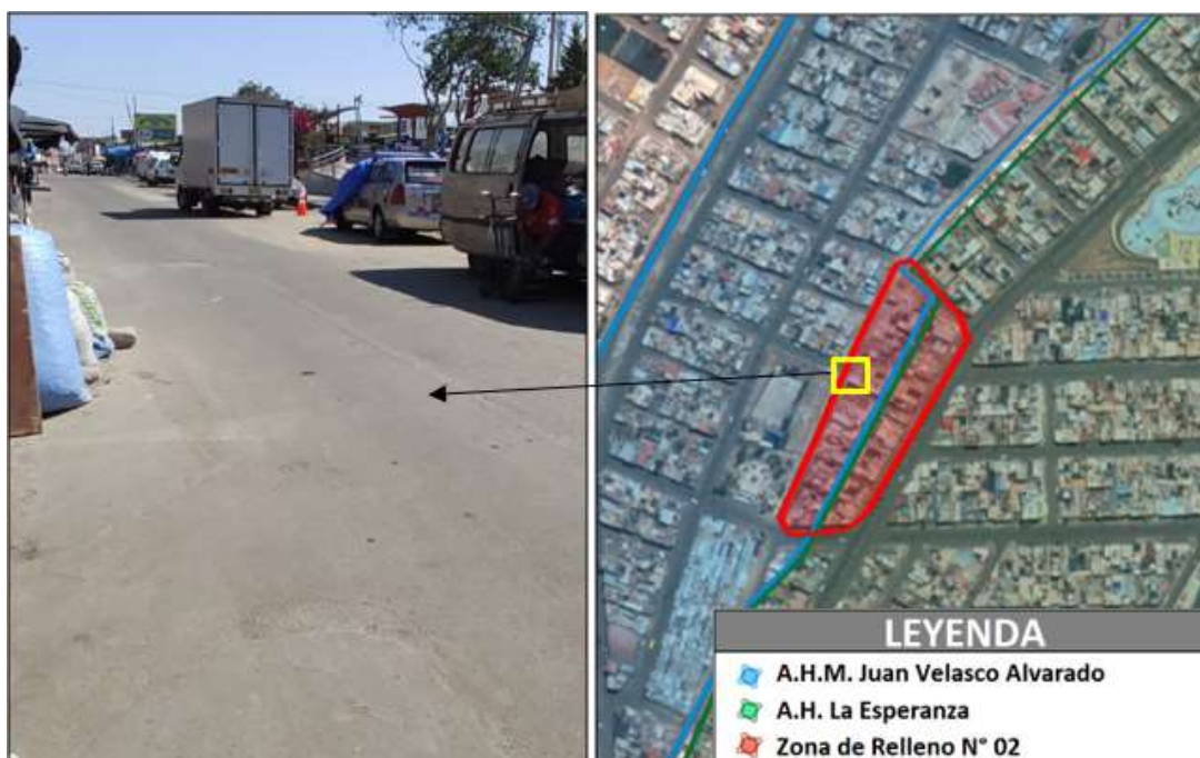
FIGURA N° 132. Resanes de carpeta asfáltica en la Calle Canadá y ubicación satelital
