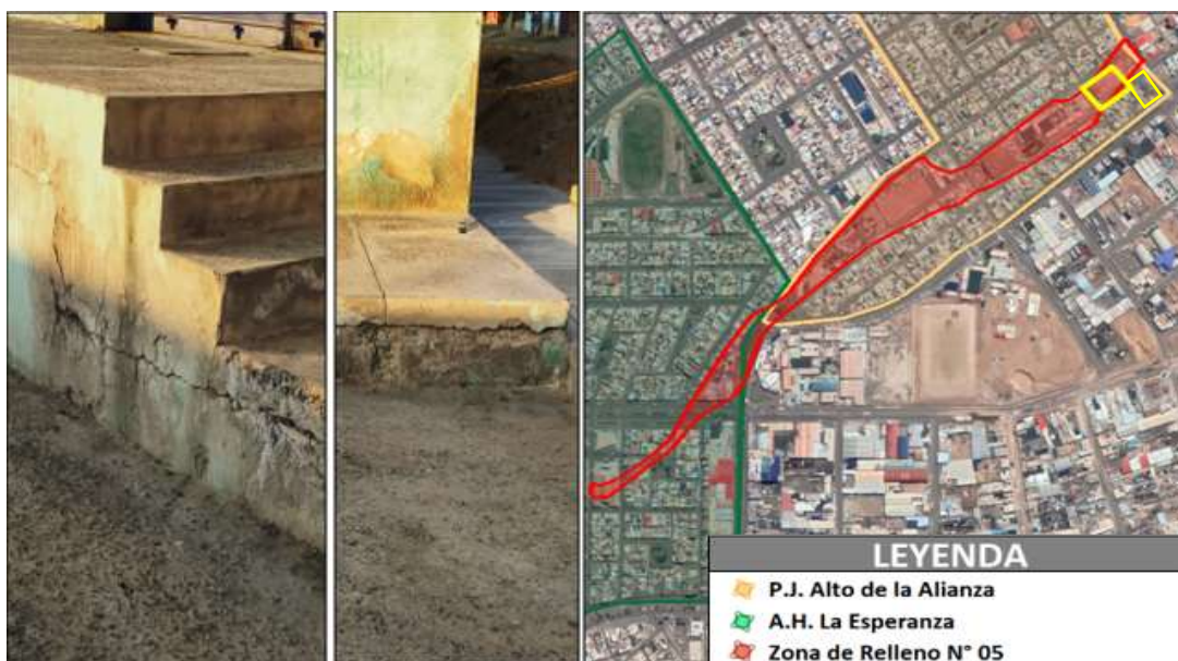
FIGURA N° 151. Presencia de graderías principales y veredas del Mercado Zonal Alto de la Alianza
