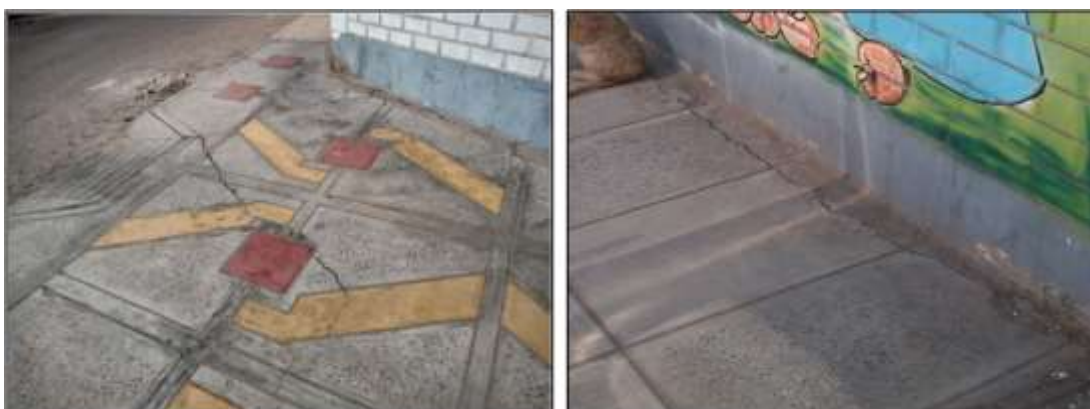
FIGURA N° 176. Presencia de Fisuras y Grietas en las veredas de la I.E.I N° 381 San José
