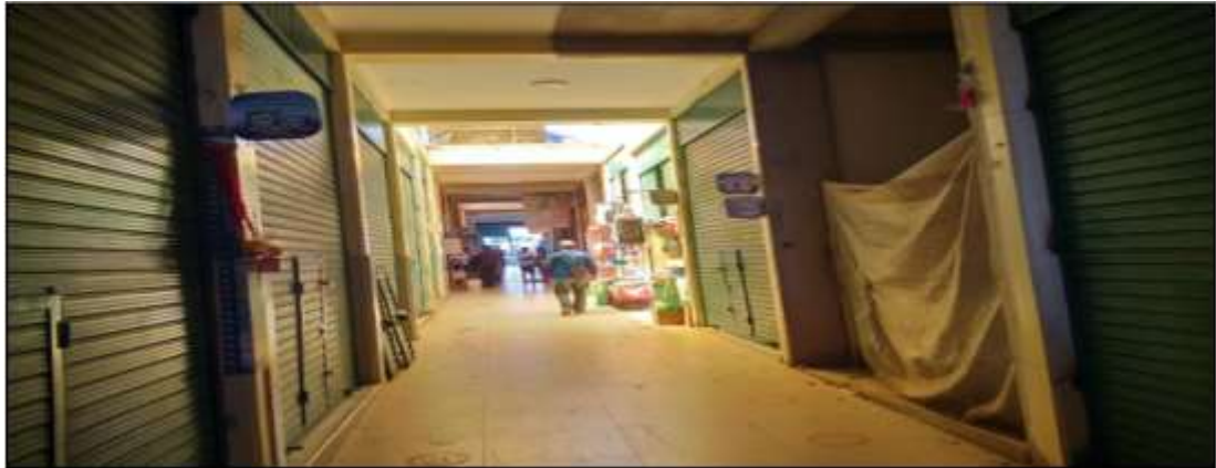
FIGURA N° 195. No presenta fisuras y grietas en el mercado comercial Intiorko
