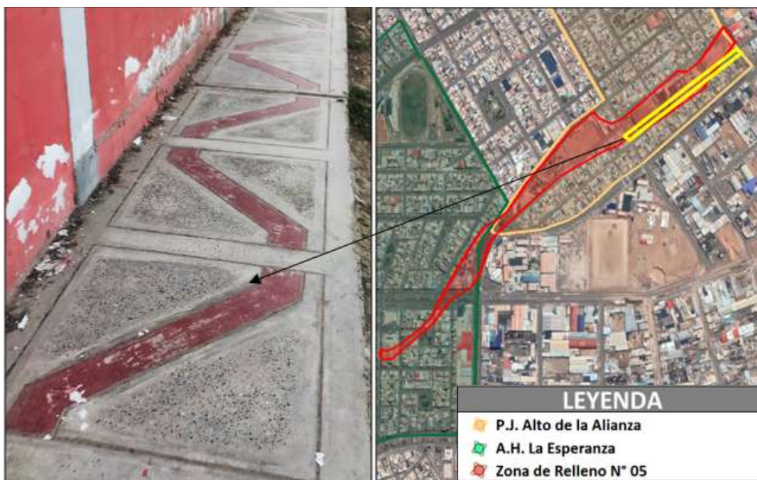
FIGURA N° 171. Presencia de desgaste en veredas de la Av. Aviación y ubicación satelital
