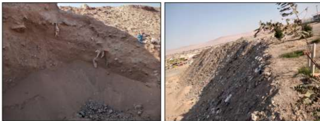
FIGURA N° 216. Presencia de relleno y desmonte en área destinada a Parque Ecológico
