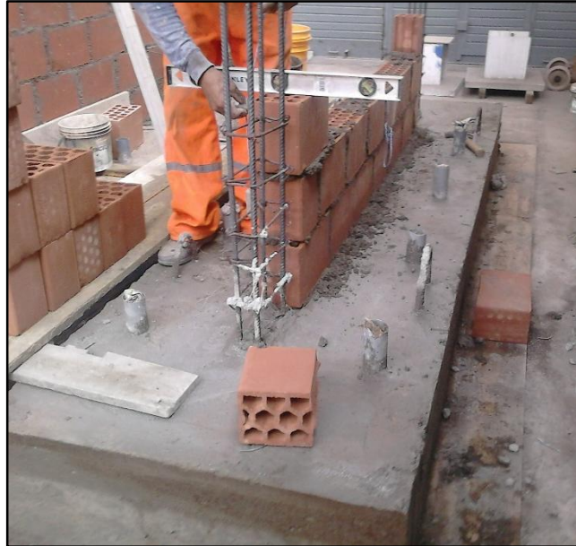
Fig. 3-10 Asentado del muro
