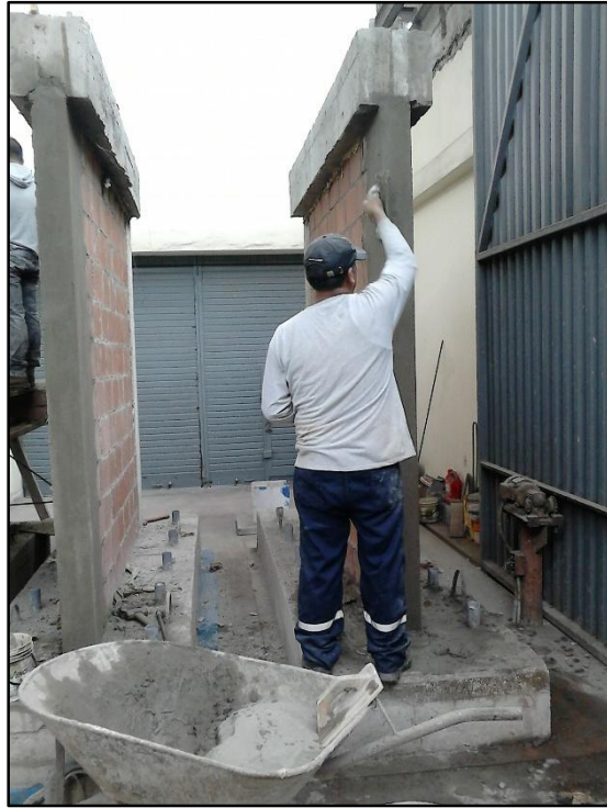
Fig. 3-20 Solaqueado de columna
