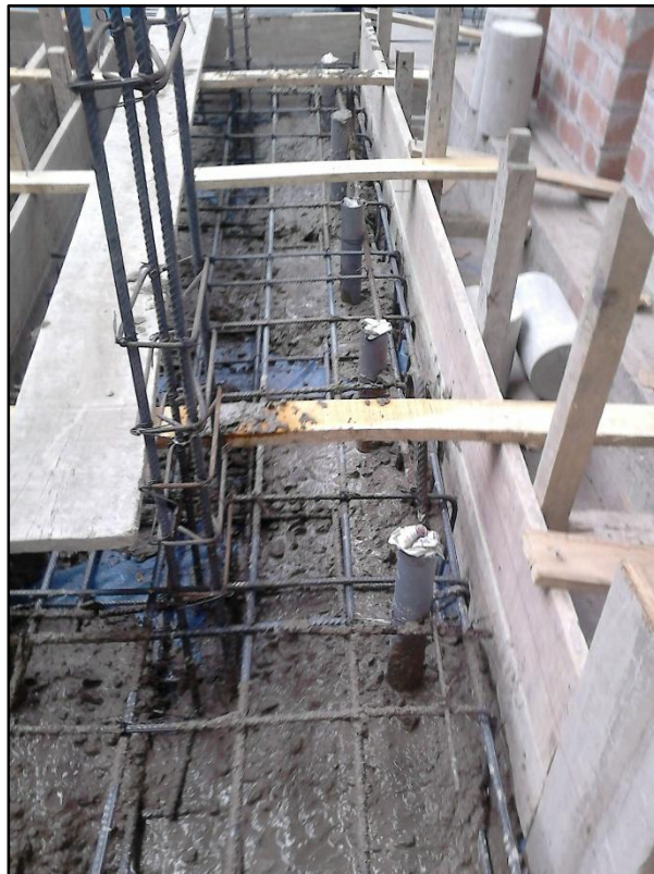
Fig. 3-8 Vaciado de la viga de cimentación
