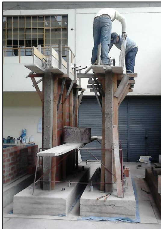
Fig. 3-17 Encofrado y colocación del acero de la viga
