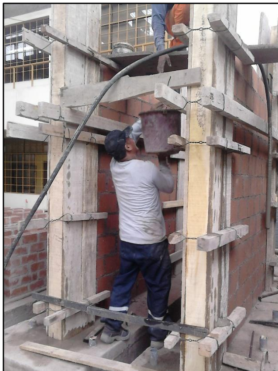
Fig. 3-14 Uso de vibradora en el vaciado de columna
