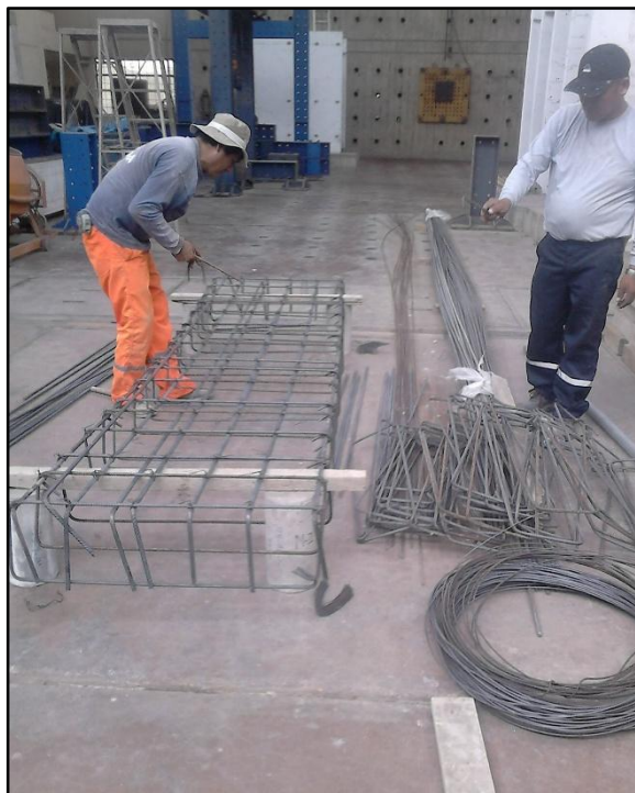
Fig. 3-4 Armado la viga de cimentación
