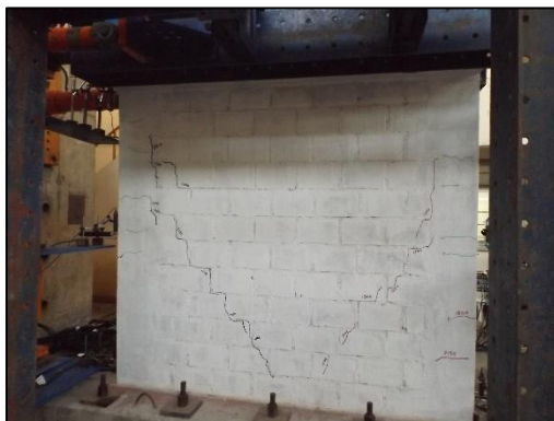
Foto 3. Grietas diagonales en la cara sur del muro para una distorsión 1/1100
