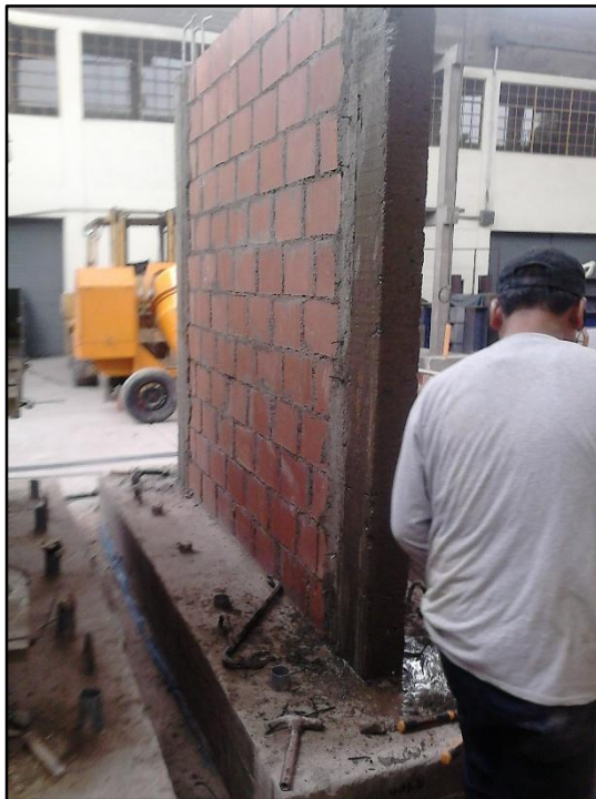
Fig. 3-16 Curado de la columna
