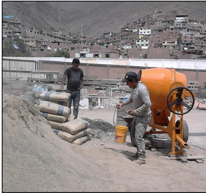
Fig. 3-7 Preparado de la mezcla
