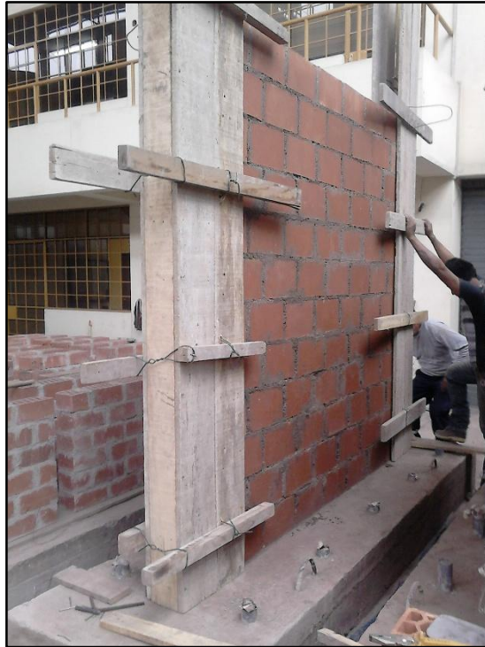
Fig. 3-13 Encofrado de la columna
