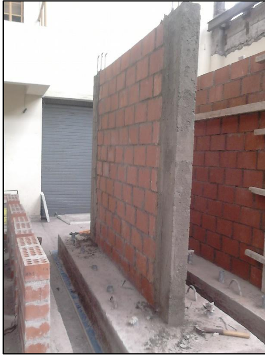
Fig. 3-15 Desencofrado de columnas
