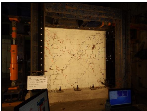
Foto 11. Acumulación de grietas cercanas las columnas, para una distorsión de 1/200 .
