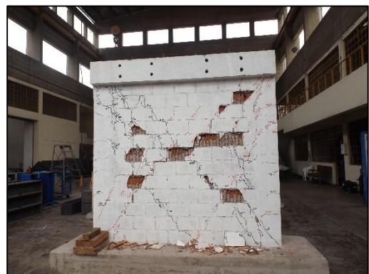
Foto 12. Estado final del muro para una distorsión 1/200 .
