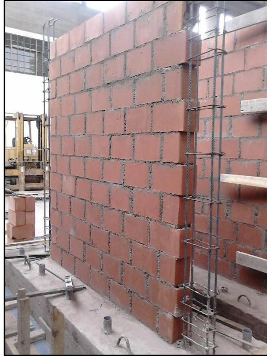
Fig. 3-12 Culminación del muro de 2.20m de altura
