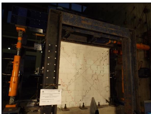
Foto 5. Grietas formadas a flexión y más grietas diagonales para una distorsión 1/550.
