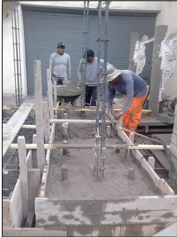
Fig. 3-9 Última capa de vaciado de la viga de cimentación
