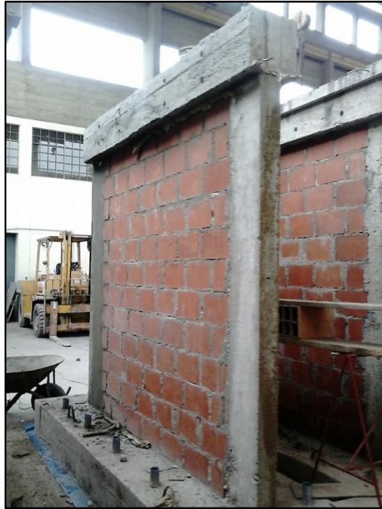
Fig. 3-18 Desencofrado de viga
