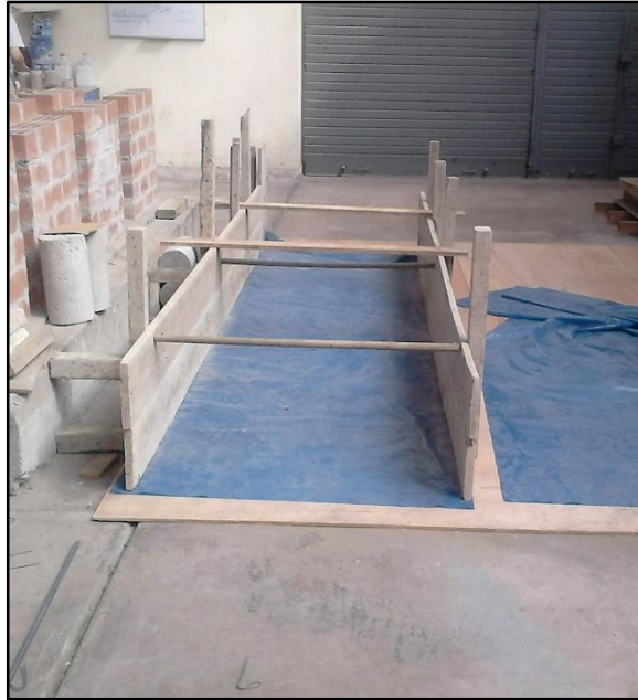
Fig. 3-3 Encofrado de la viga de cimentación
