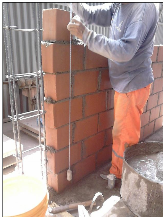
Fig. 3-11 1ra. Jornada de trabajo y control de verticalidad del muro
