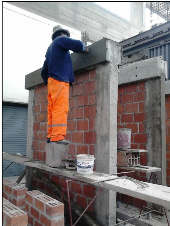
Fig. 3-19 Solaqueado de viga
