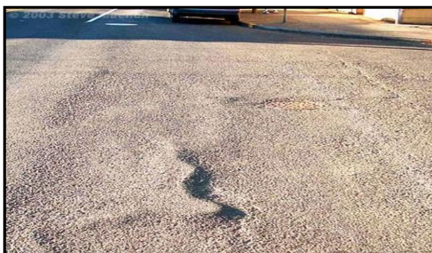
Figura 47: Desplazamiento
