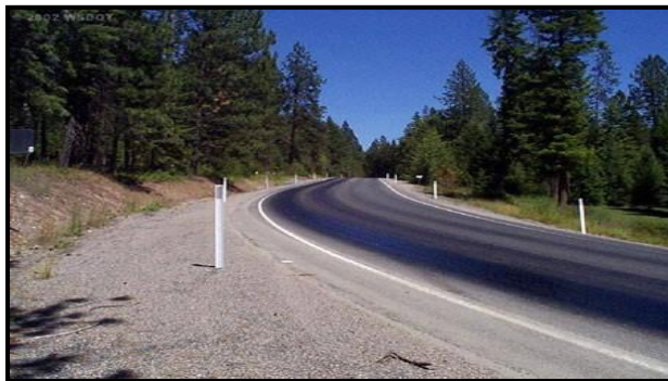
Figura 12: Exudación de severidad alta
