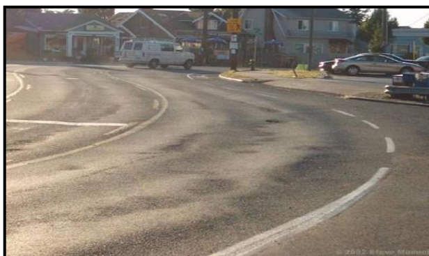
Figura 48: Desplazamiento de severidad media
