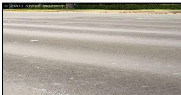
Figura 45: Ahuaellamiento de severidad media
