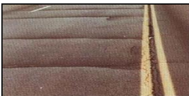
Figura 4: Grietas por Reflexión
