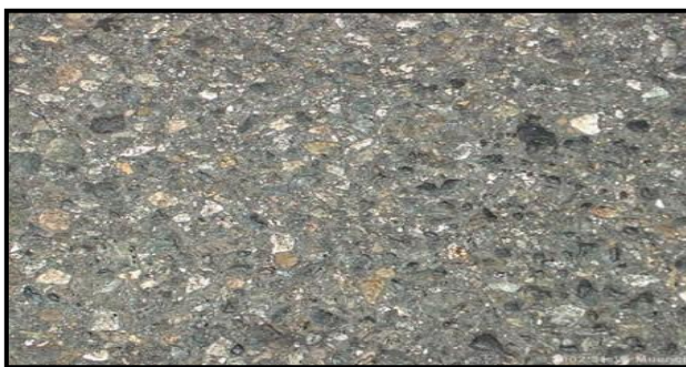
Figura 38: Agregados pulidos
