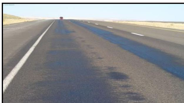
Figura 11: Exudación de severidad media
