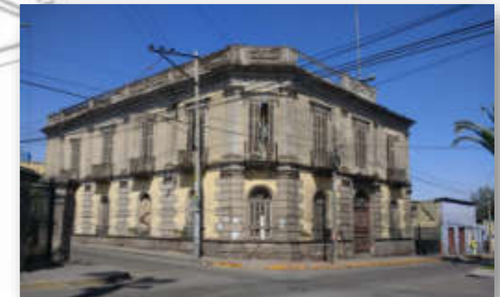
CASONA ABANDONADA Y DETERIORADA
