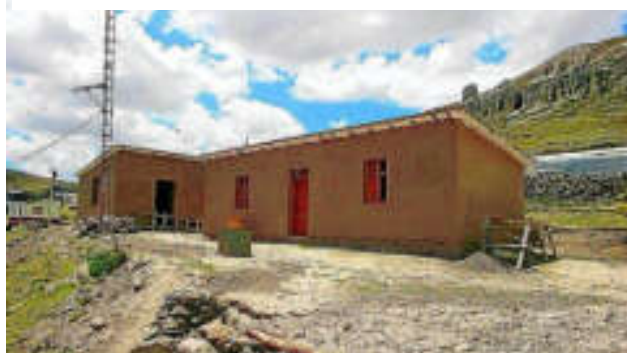
Figura 90: Vivienda de adobe
