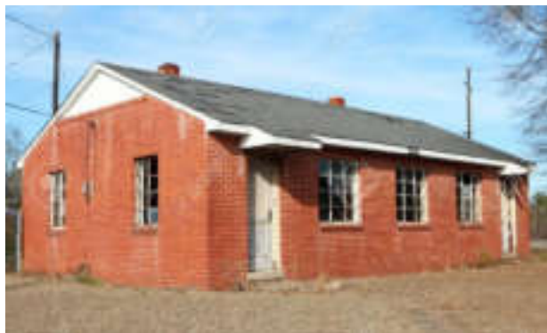
Figura 82: Vivienda con ladrillo de arcilla
