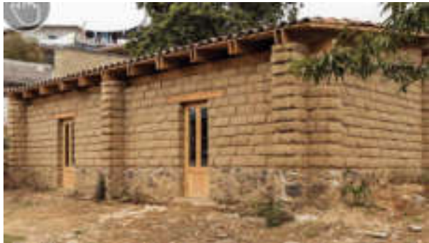
Figura 84: Vivienda de adobe
