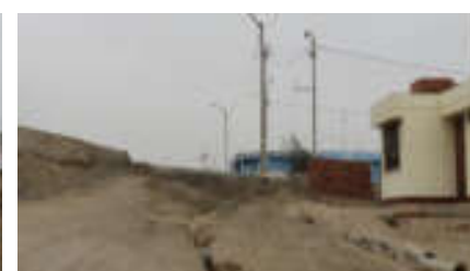
Figura 57: Calle 02 Fuente: Elaboración propia
