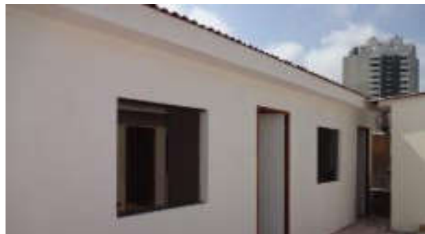
Figura 85: Vivienda de Drywall
