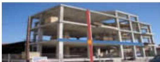
Figura 105 Viga, columna y nodo en un Sistema Tradicional Aporticado
