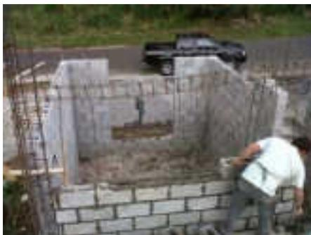
Figura 79 Construcción en bloqueta de concreto
