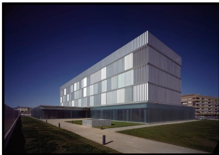
Figura 11: Fachada principal del proyecto Jefatura Superior de Policía en Logroño, España. Fuente: Archdaily, 2014
