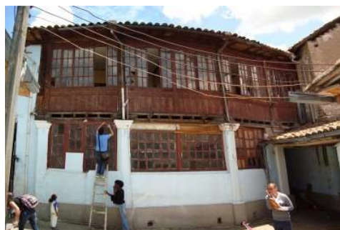
Ilustración 75 , Vista antes de la intervención.
