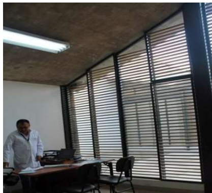
Ilustración 79, Vista interior de la celosía.
