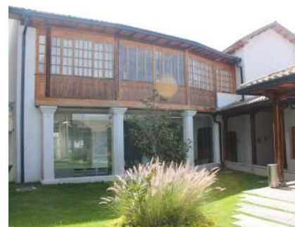
Ilustración 76 , Vista después de la intervención.
