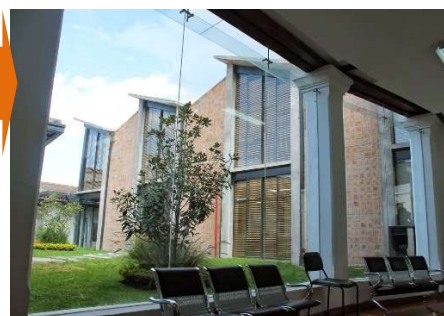
Ilustración 12 , Tratamiento exterior del centro ambulatorio de salud mental San Lázaro, Ecuador
