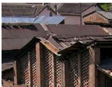
Ilustración 77 , Vista del antes de los galpones.
