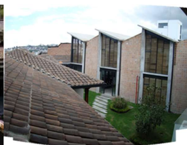
Ilustración 78 , Vista después de la intervención.
