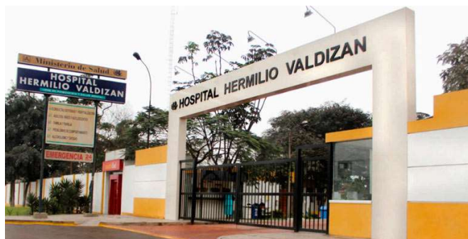
Ilustración 34, Vista del ingreso principal desde la Av. Nicolás de Ayllon.
