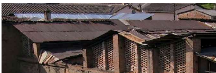
Ilustración 74, Vista exterior del galpón.
