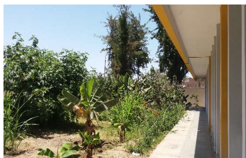
Ilustración 13 , Tratamiento exterior, del hospital de día del hospital Hipólito Unanue, Tacna
