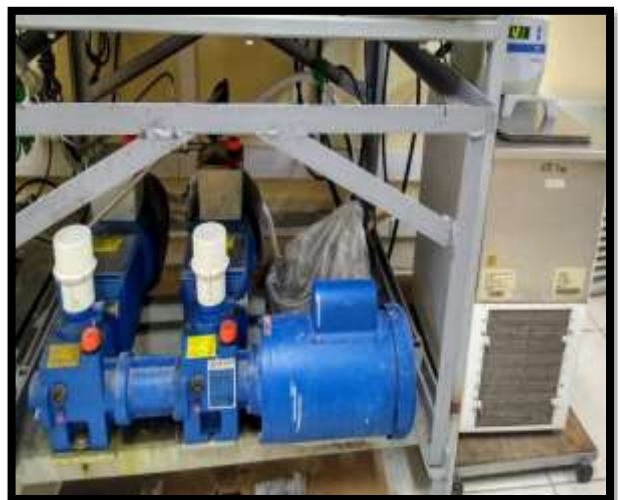
Figura 34. Bombas de circulación de CO2
