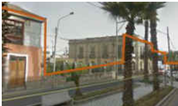
Figura 63: Vista de bajada de la Av. Bolognesi Fuente Google Maps
