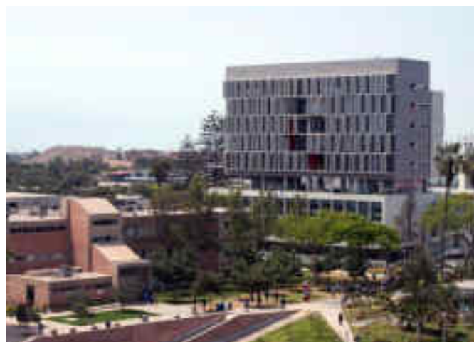
Figura 34: Fachada muestra N°4
