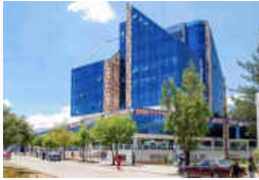
Figura 30: Fachada muestra N°3
