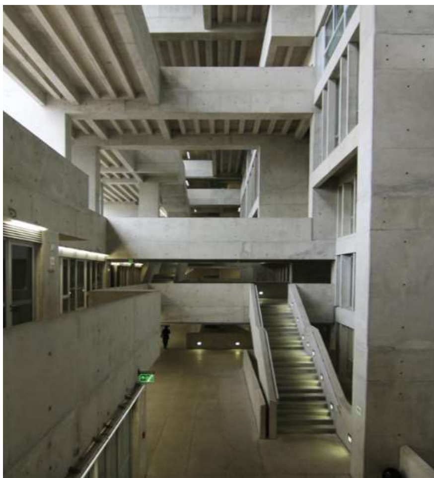
Figura 53: Vista interior de la UTECH.
