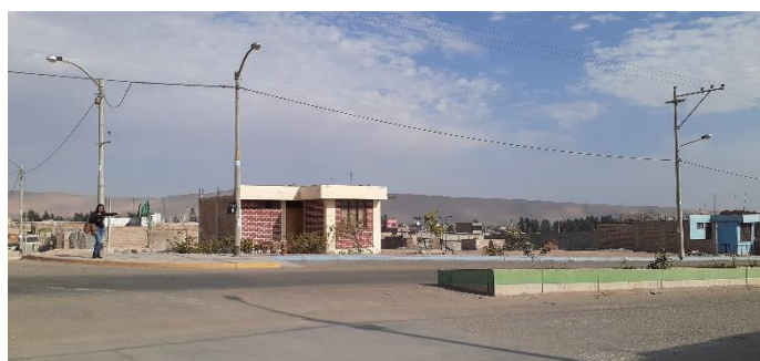
FIGURA 58: Anexo - fotografía de vivienda otorgada por el banco de materiales en el sector.
