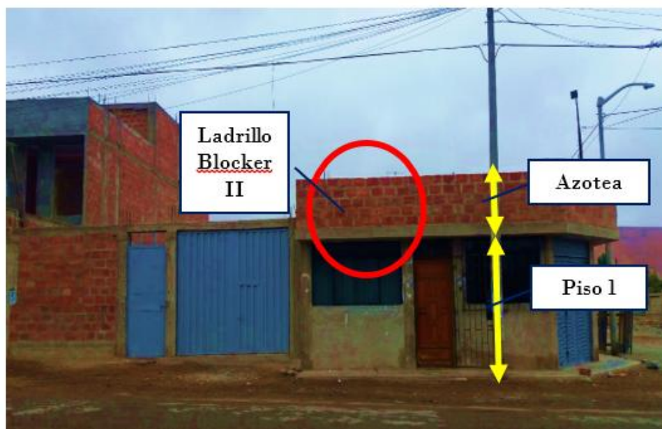
Foto 9. Vista de vivienda 08. Vivienda edificada con la unidad de albañilería de arcilla cocida Blocker II, presenta 1 piso con azotea.
