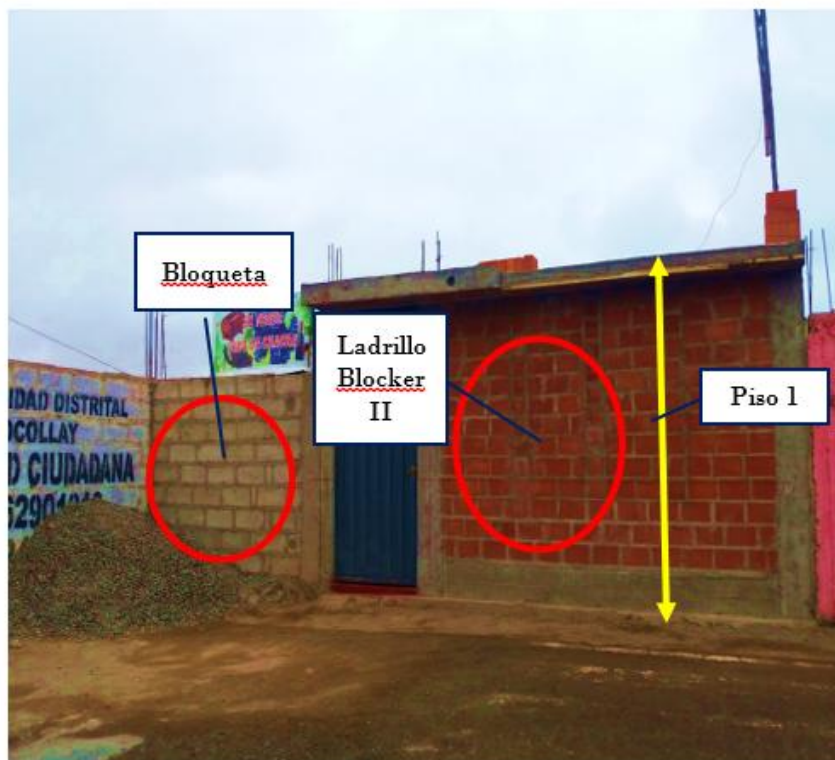
Foto 17. Vista de vivienda 16. Vivienda edificada con la unidad de albañilería de arcilla cocida Blocker II, presenta 1 pisos sin azotea y se observa el cerco de Bloqueta.
