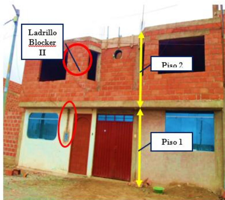
Foto 6. Vista de vivienda 05. Vivienda recientemente edificada con la unidad de albañilería de arcilla cocida Blocker II, presenta 2 pisos sin azotea.
