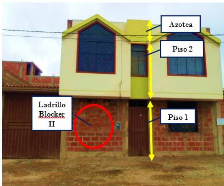
Foto 8. Vista de vivienda 07. Vivienda edificada con la unidad de albañilería de arcilla cocida Blocker II, presenta 2 pisos con azotea.
