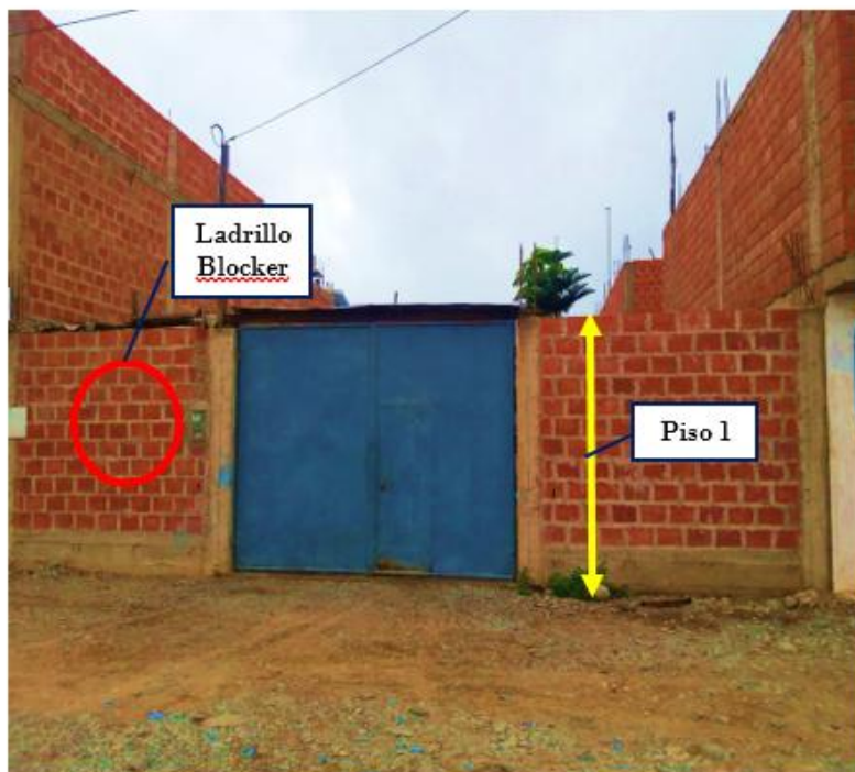
Foto 7. Vista de vivienda 06. Vivienda edificada con la unidad de albañilería de arcilla cocida Blocker II, presenta 1 pisos sin azotea, techo flexible.
