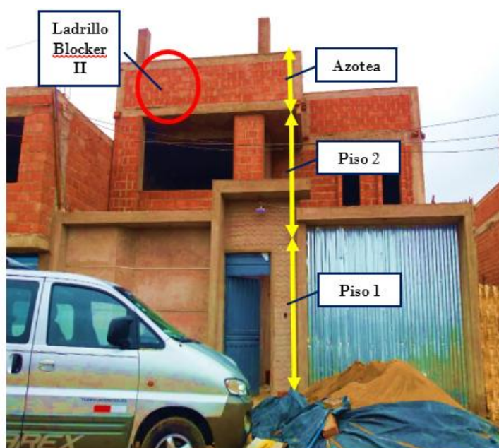
Foto 5. Vista de vivienda 04. Vivienda recientemente edificada con la unidad de albañilería de arcilla cocida Blocker II, presenta 2 pisos con azotea.
