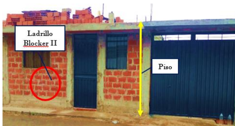
Foto 11. Vista de vivienda 10. Vivienda edificada con la unidad de albañilería de arcilla cocida Blocker II, presenta 1 piso.
