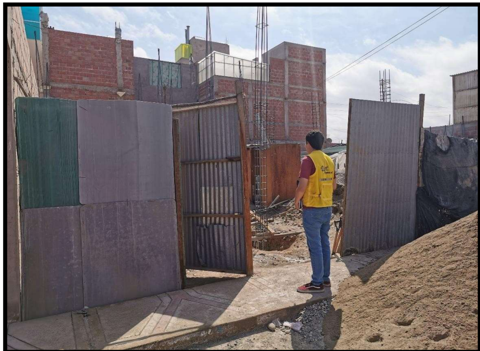
Foto 8: Construcción de edificio Multifamiliar.
