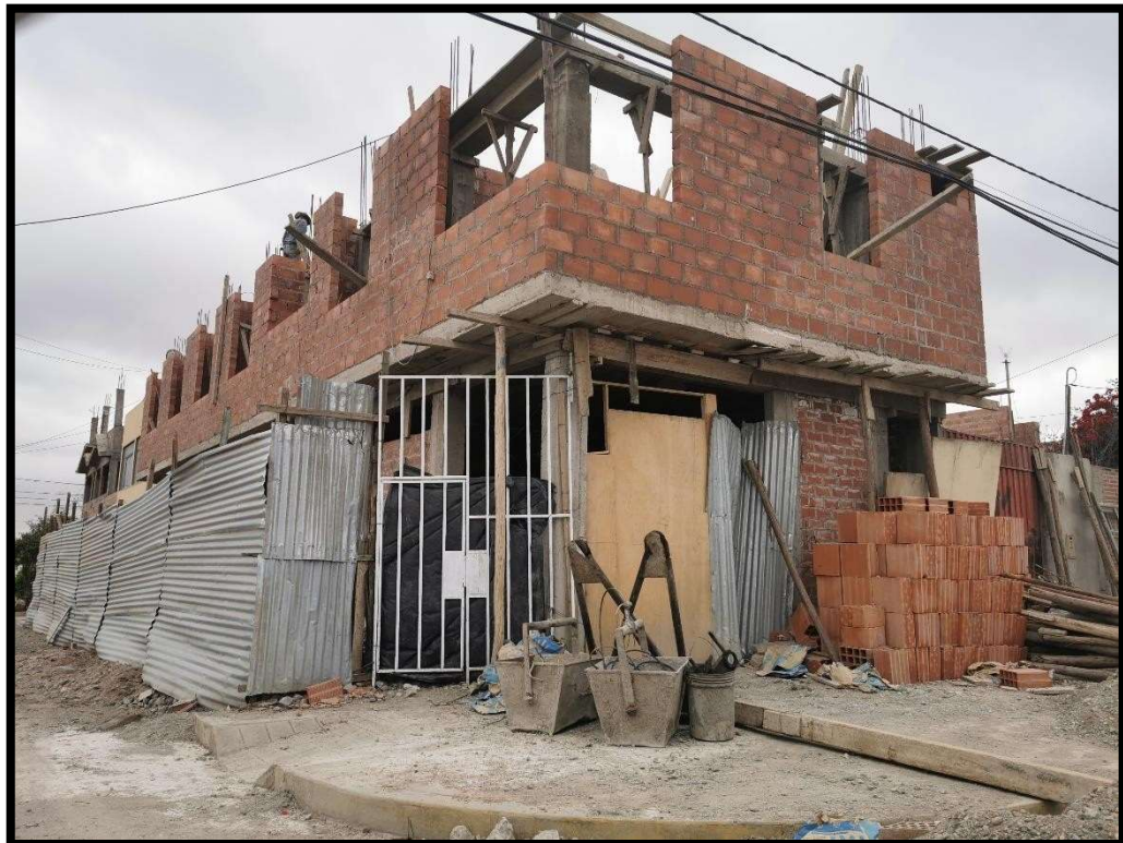
Foto 6: Construcción de vivienda Multifamiliar.
