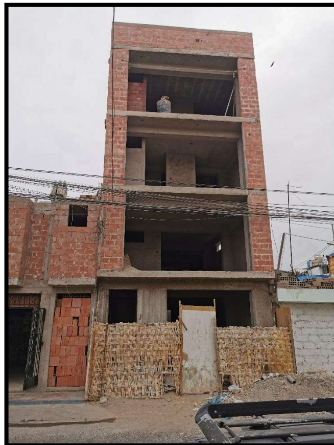
Foto 24: Construcción de Edificio Multifamiliar.
