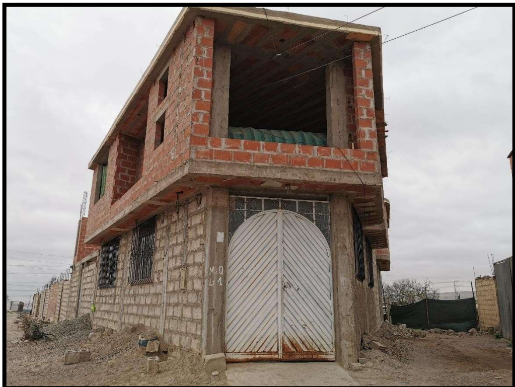
Foto 22: Construcción de Vivienda Unifamiliar con Bloquetas y ladrillos.
