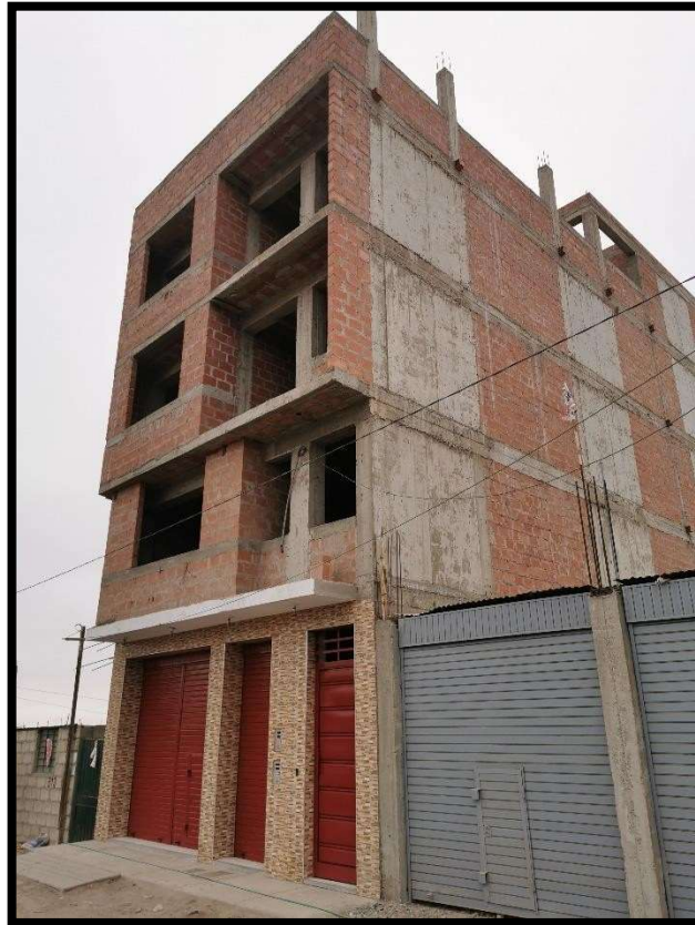
Foto 23: Construcción de Edificio Multifamiliar.
